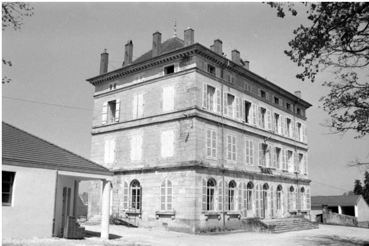
Logement patronal vu de trois quarts gauche.
