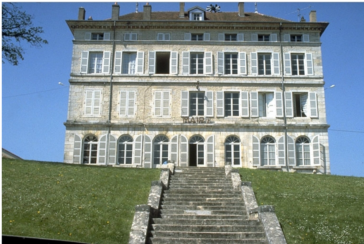
Façade antérieure du logement patronal.
