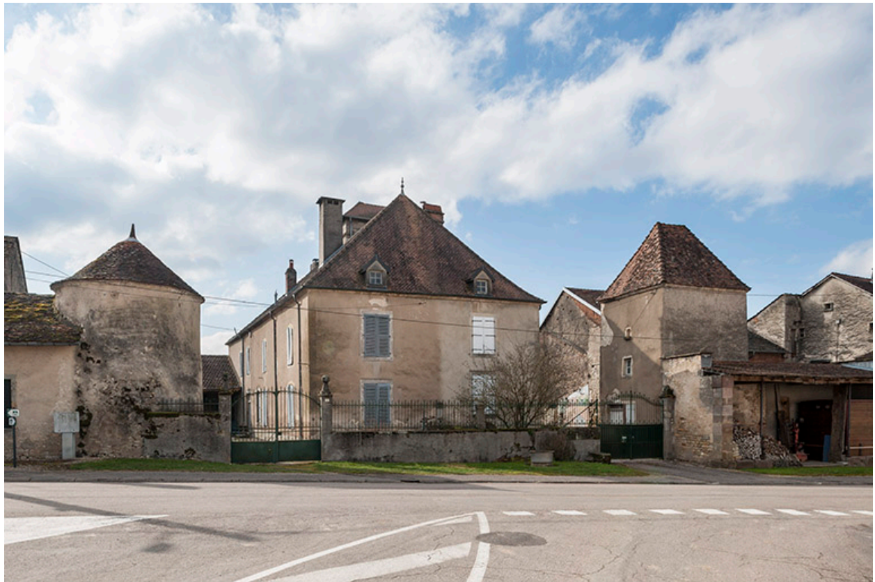
Vue depuis le nord.
