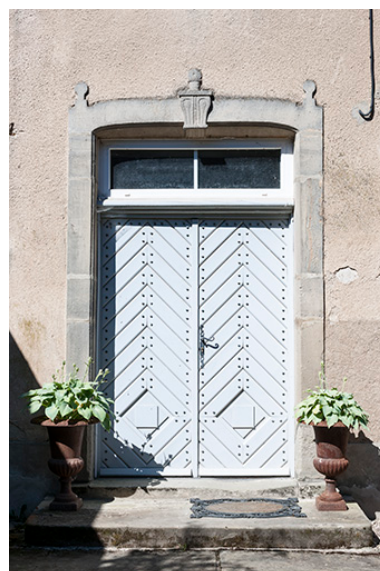
La porte d'entrée, façade est. Phot. Jérôme Mongreville IVR43_20167001075NUC4A
