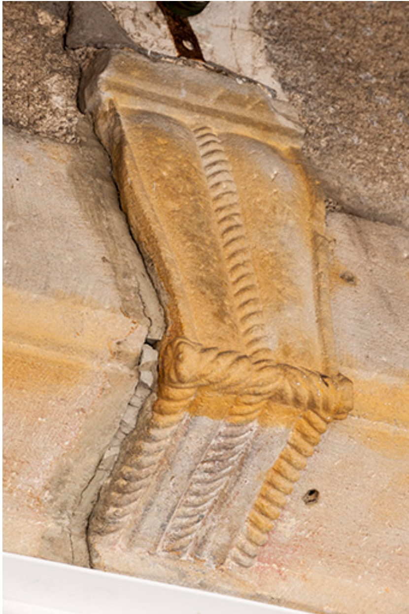
détail de la porte d'entrée, façade ouest.
