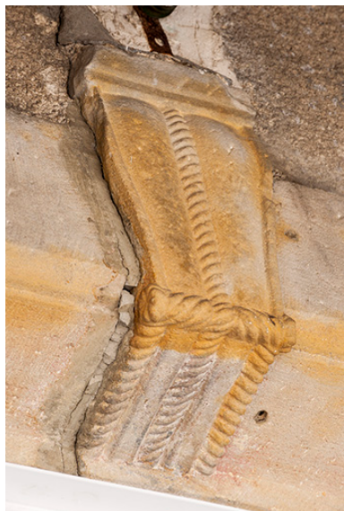
détail de la porte d'entrée, façade ouest.
