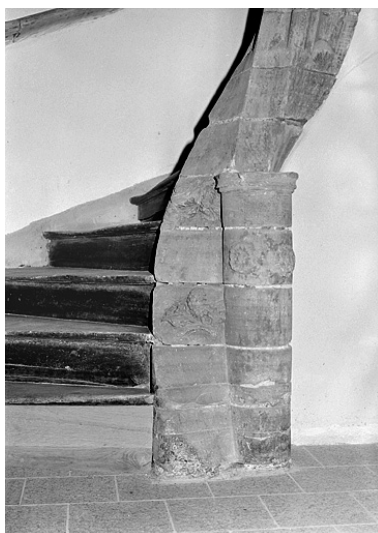
Départ de l'escalier. Phot. Jérôme Mongreville IVR43_19872500464X
