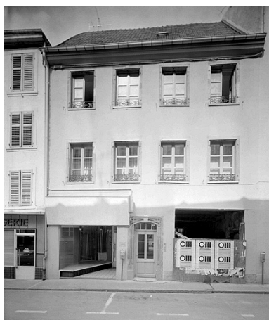
Façade sur rue. Phot. Jérôme Mongreville IVR43_19872501120V
