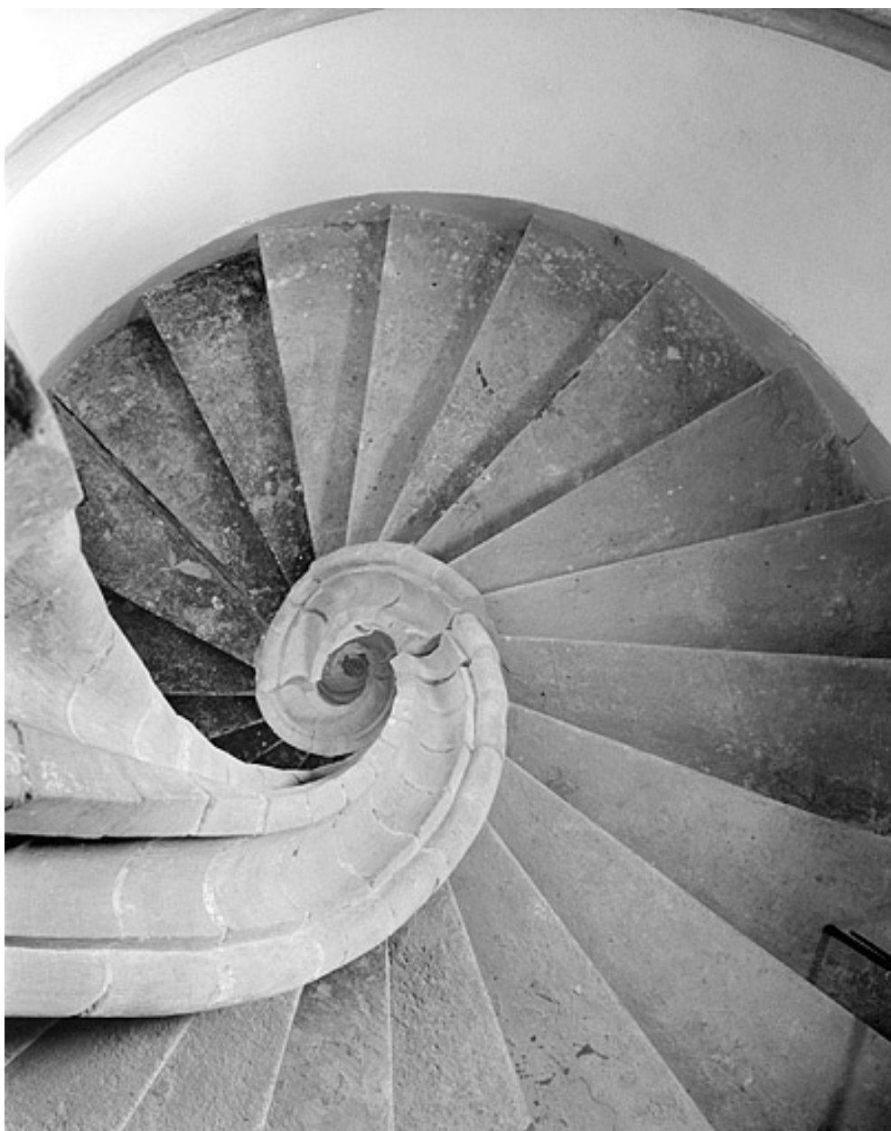
Escalier vu du niveau des combles.
