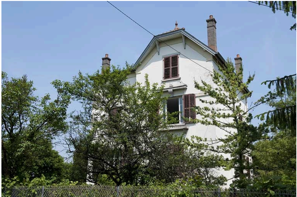
Etage supérieure d'une maison.
