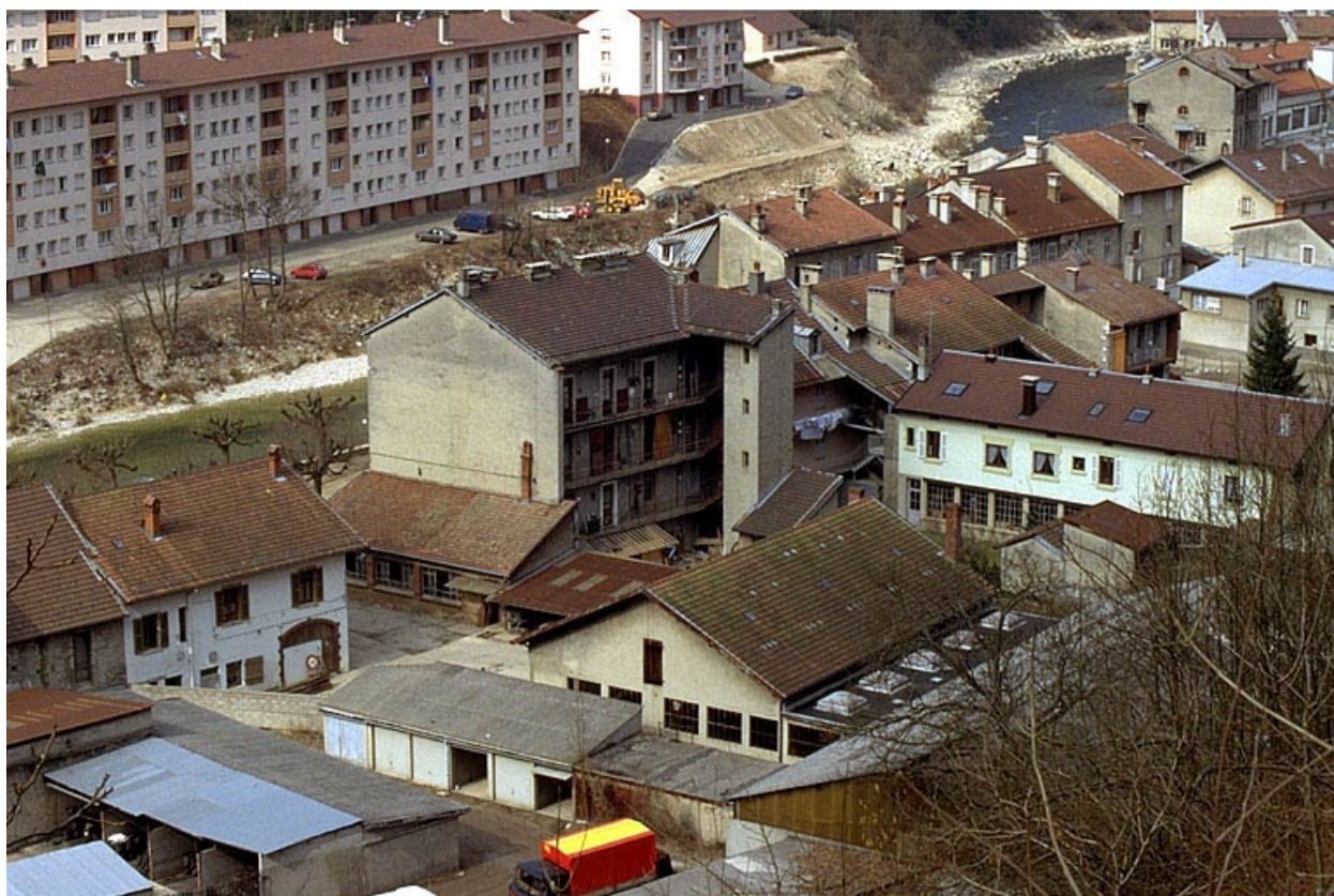
Vue d'ensemble plongeante depuis le sud-est.
