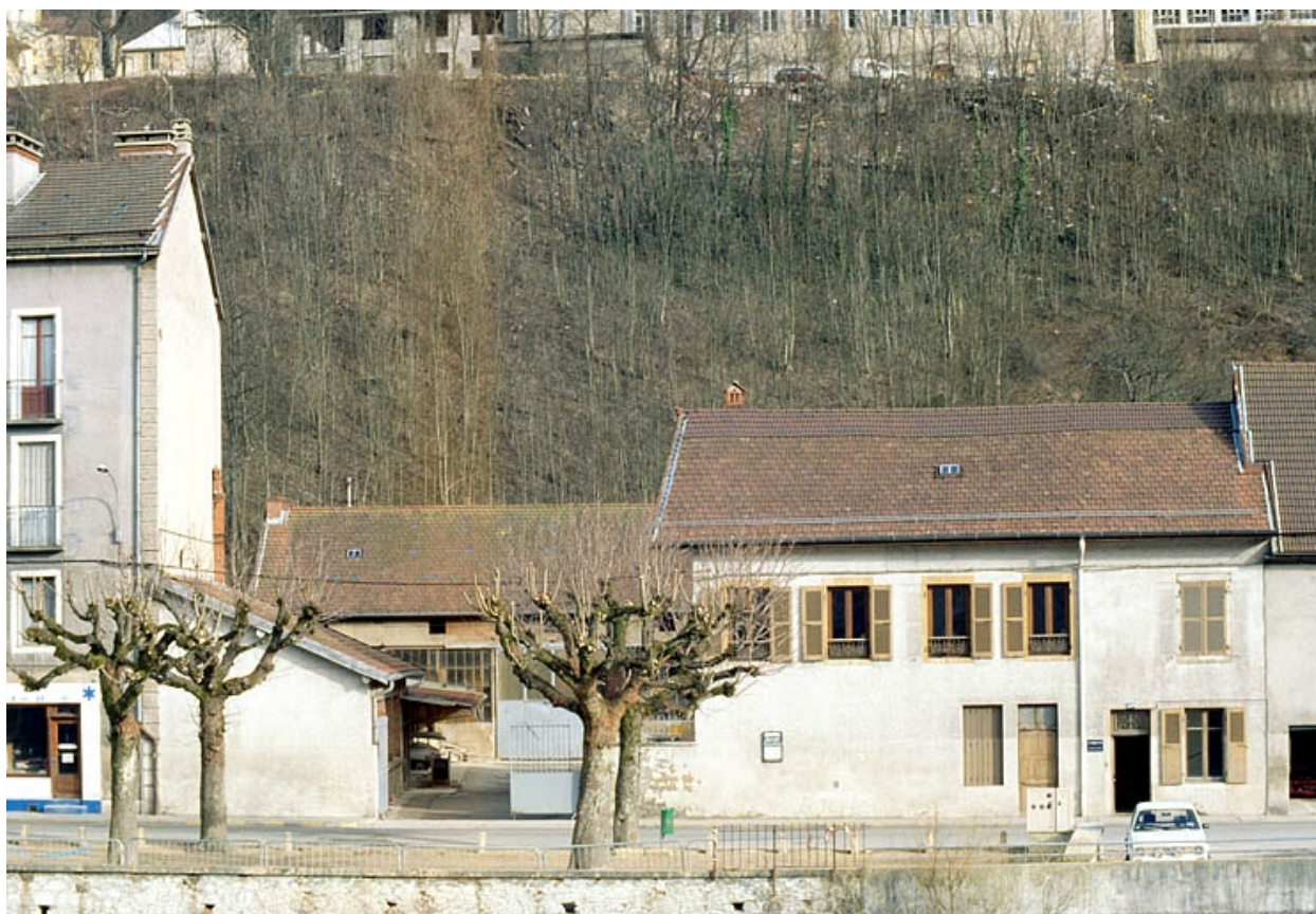
Entrée de l'usine.
