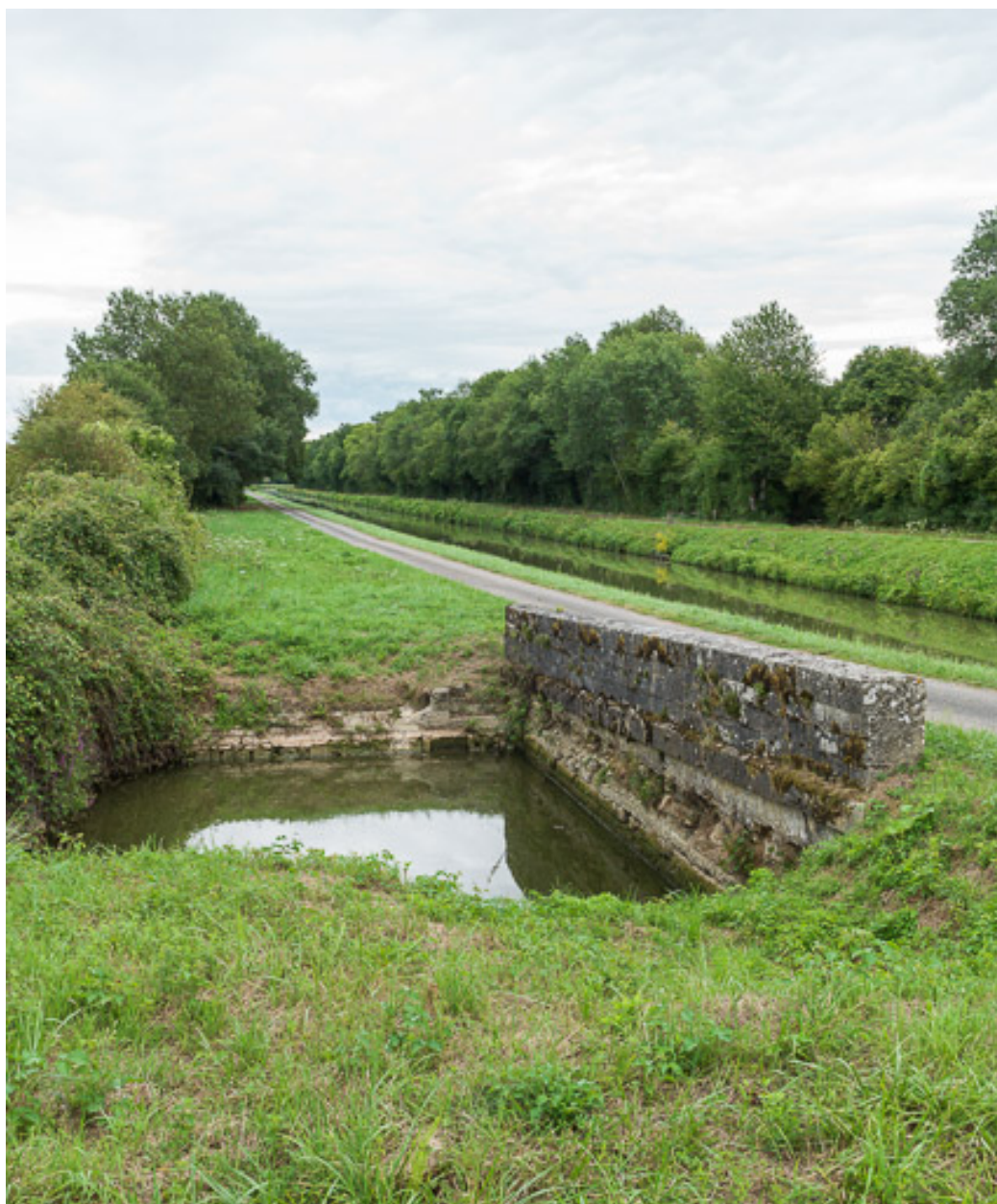
Vue de l'aqueduc.
