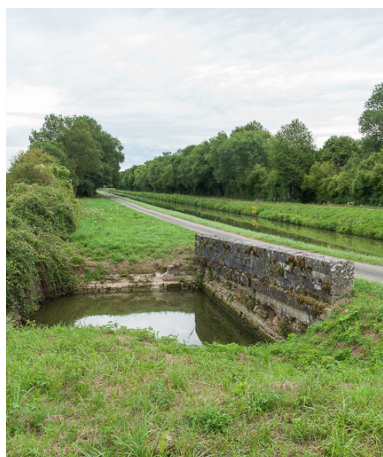
Vue de l'aqueduc.
