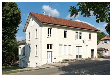
Façades antérieure et latérale gauche.
