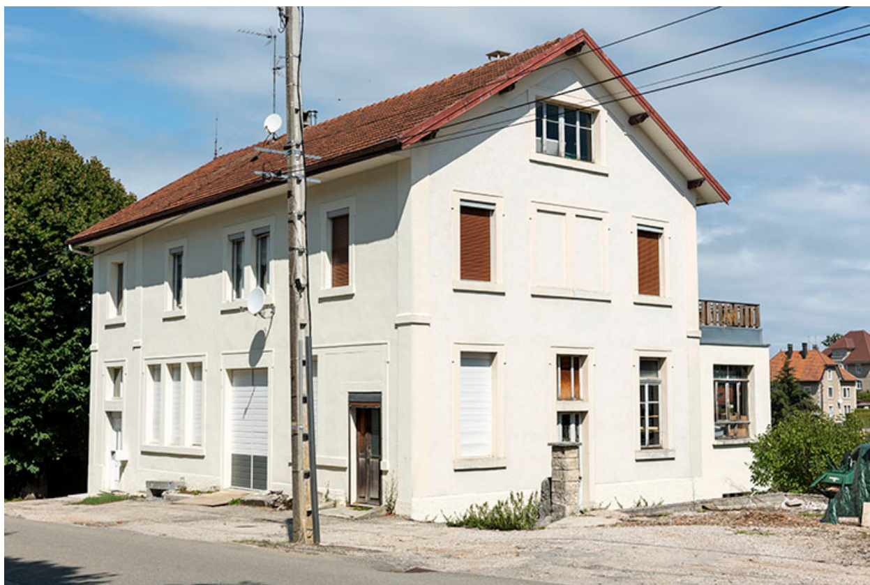
Façades antérieure et latérale droite.
