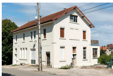
Façades antérieure et latérale droite.
