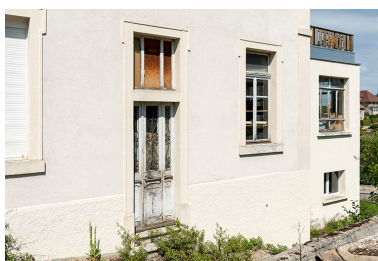
Façade latérale droite : baies du rez-de-chaussée.
