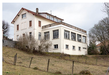
Façades postérieure et latérale droite.
