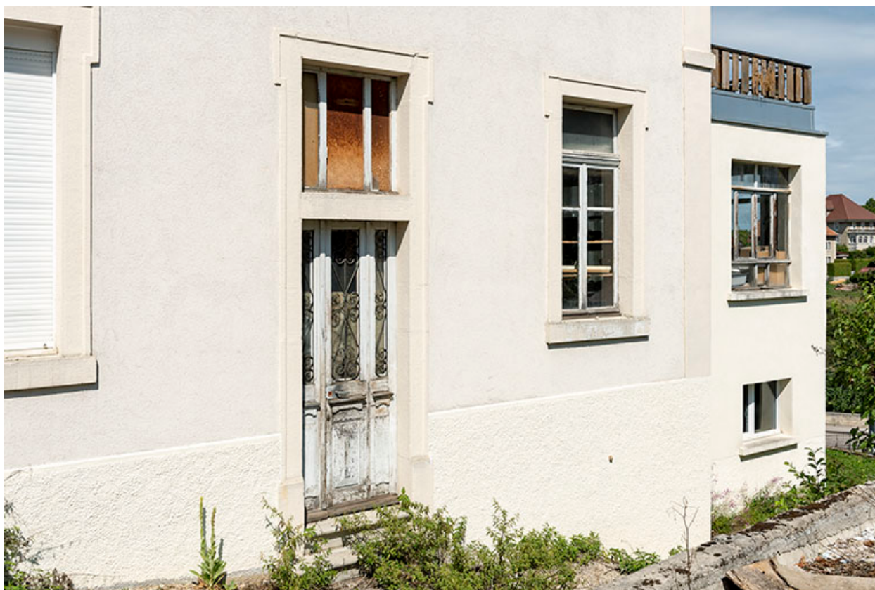
Façade latérale droite : baies du rez-de-chaussée.
