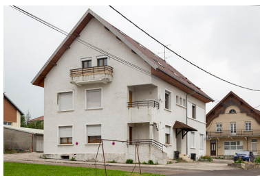
Façades latérale gauche et antérieure. Phot. Yves Sancey IVR43_20122502247NUC2A
