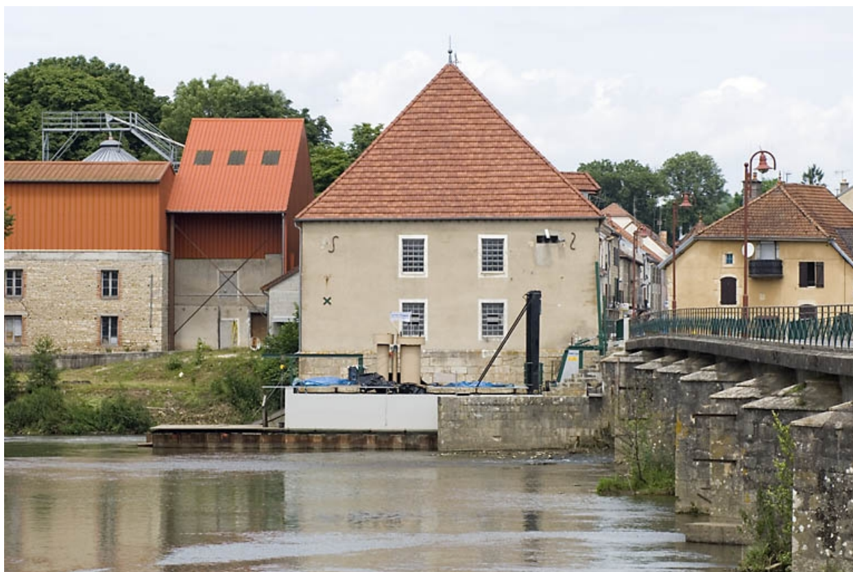
Vue depuis le sud.
