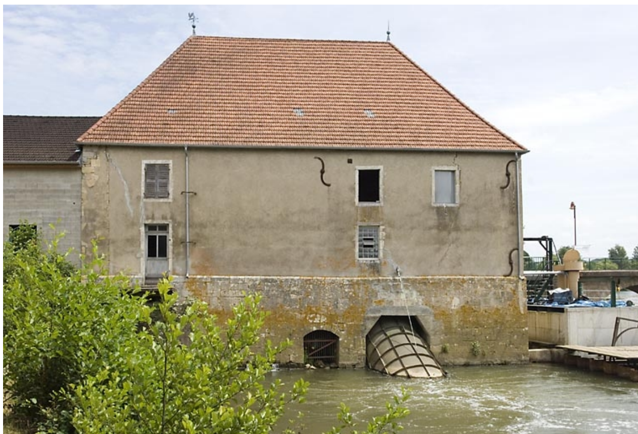
Façade postérieure du moulin.
