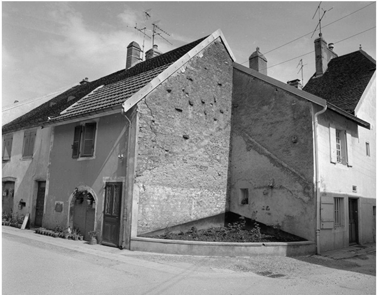
Façades antérieure et latérale droite.
