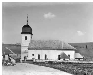
Extérieur : façade latérale droite. Phot. Yves Sancey IVR43_19782500126V
