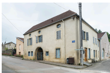
La rue Bontemps : n° 42, vue de trois quarts. Phot. Jérôme Mongreville IVR43_20217000255NUC4A
