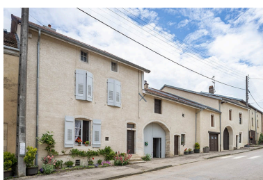
La rue Bontemps : n° 39 et 41 en direction du sud. Phot. Jérôme Mongreville IVR43_20217000251NUC4A
