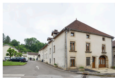
La rue Bontemps : n° 40 et immeubles bordant la rue Charles-Rech au nord. Phot. Jérôme Mongreville IVR43_20217000253NUC4A
