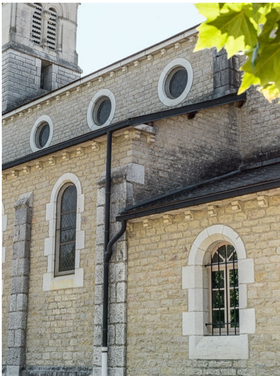
Détail élévation est, côté chevet.
