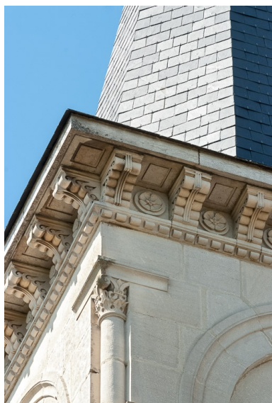
Clocher, détail des modillons. Phot. Pierre-Marie Barbe-Richaud IVR26_20162100275NUC2A
