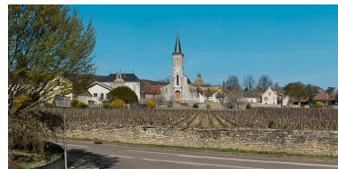
Vue d'ensemble. Phot. Pierre-Marie Barbe-Richaud IVR26_20122101015NUC4AQ
