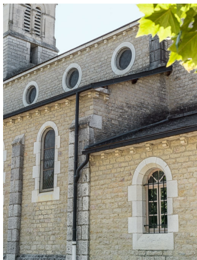
Détail élévation est, côté chevet.
