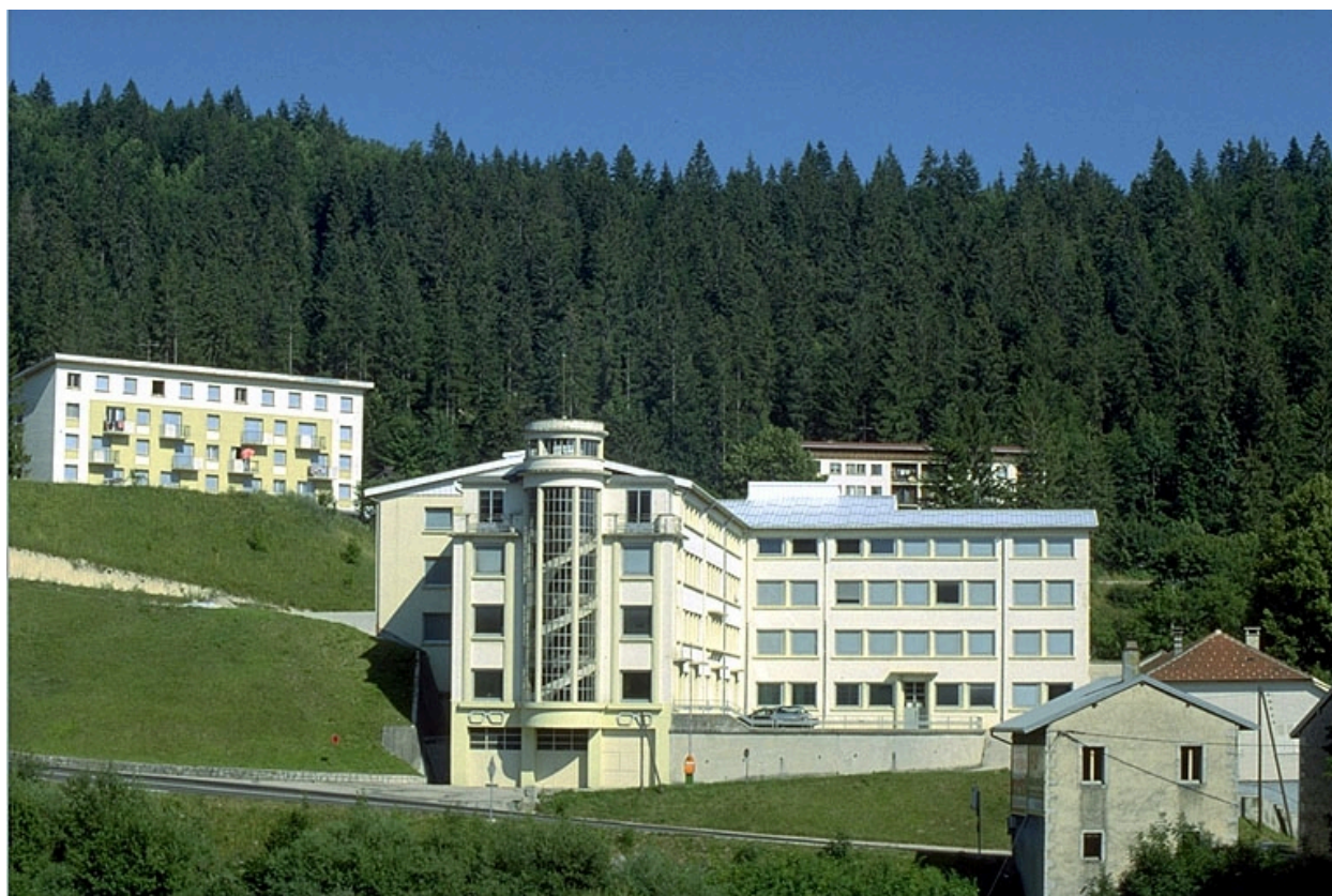
Morbier : usine d'horlogerie dite Manufacture d'Horlogerie Girod, usine de lunetterie Bourgeois.
