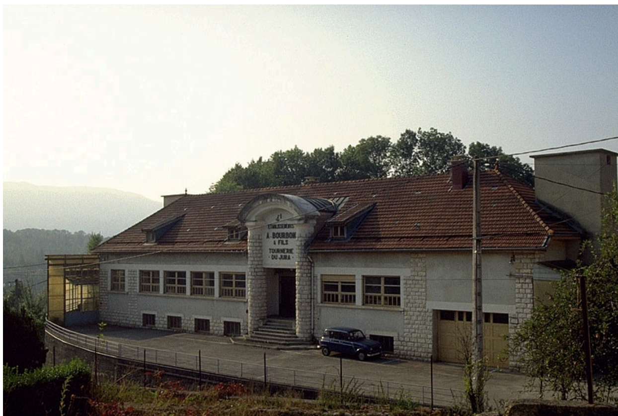
Ravilloles : usine de tournerie, usine d'articles en matière plastique Bourbon Industrie.
