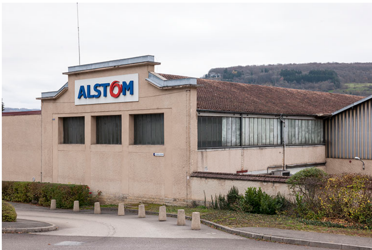
Mur-pignon de l'ancienne hall ouest.
