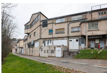
Façades sud de l'atelier de fabrication. Phot. Jérôme Mongreville IVR43_20162500198NUC4A
