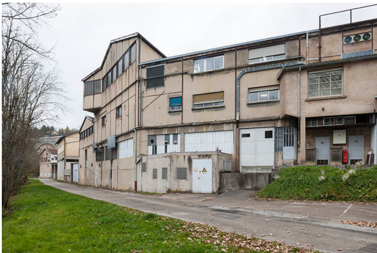
Façades sud de l'atelier de fabrication.
