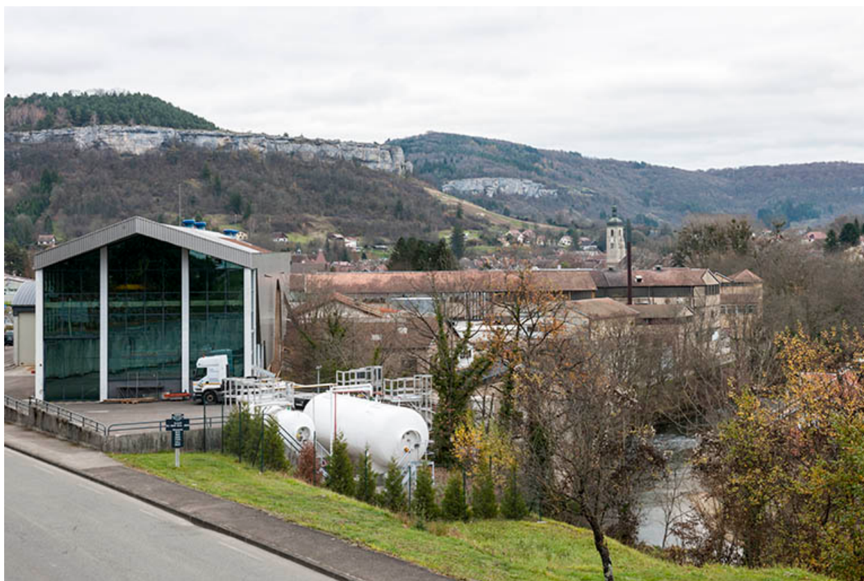
Vue d'ensemble depuis l'ouest.
