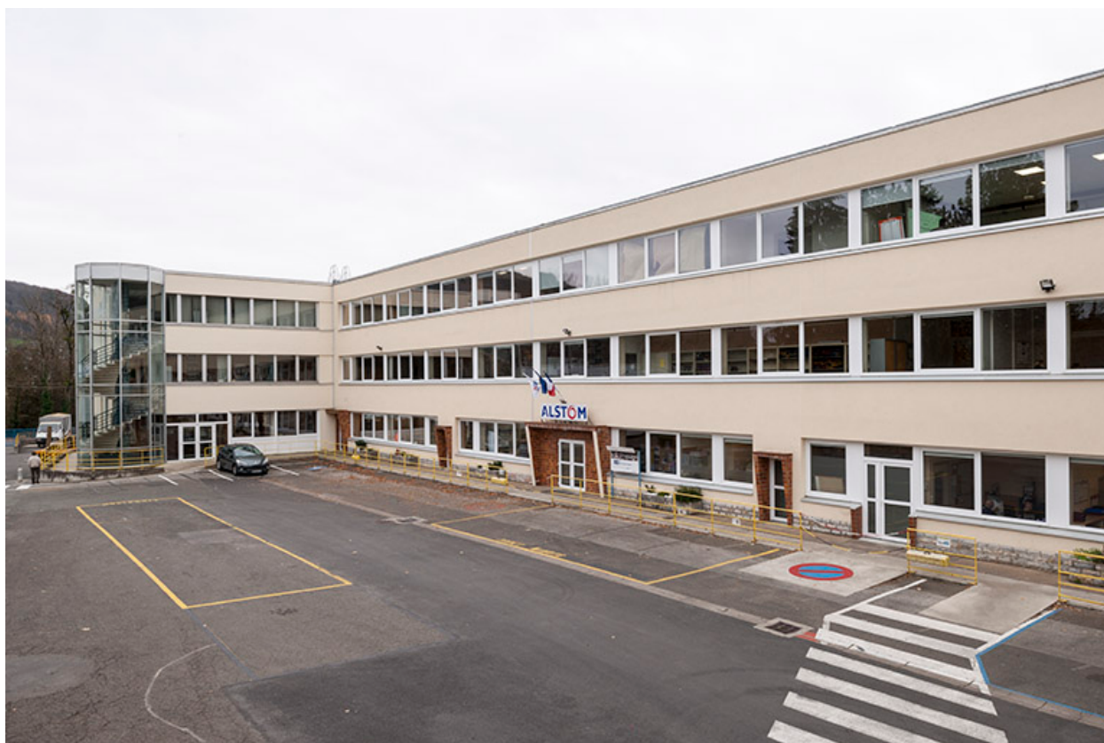
Bâtiment administratif depuis l'entrée.
