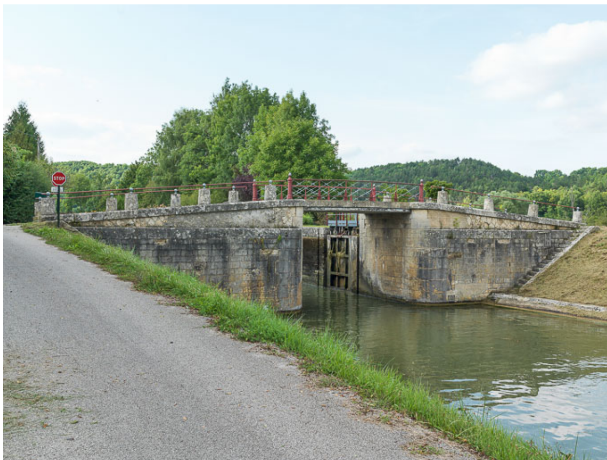
Vue d'ensemble du pont.
