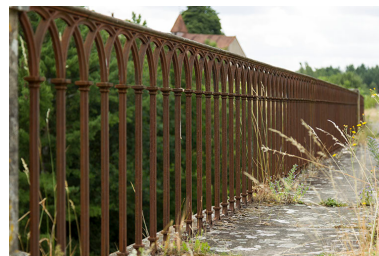
Détail du garde-corps. Phot. Sonia Dourlot IVR43_20157000587NUC2A
