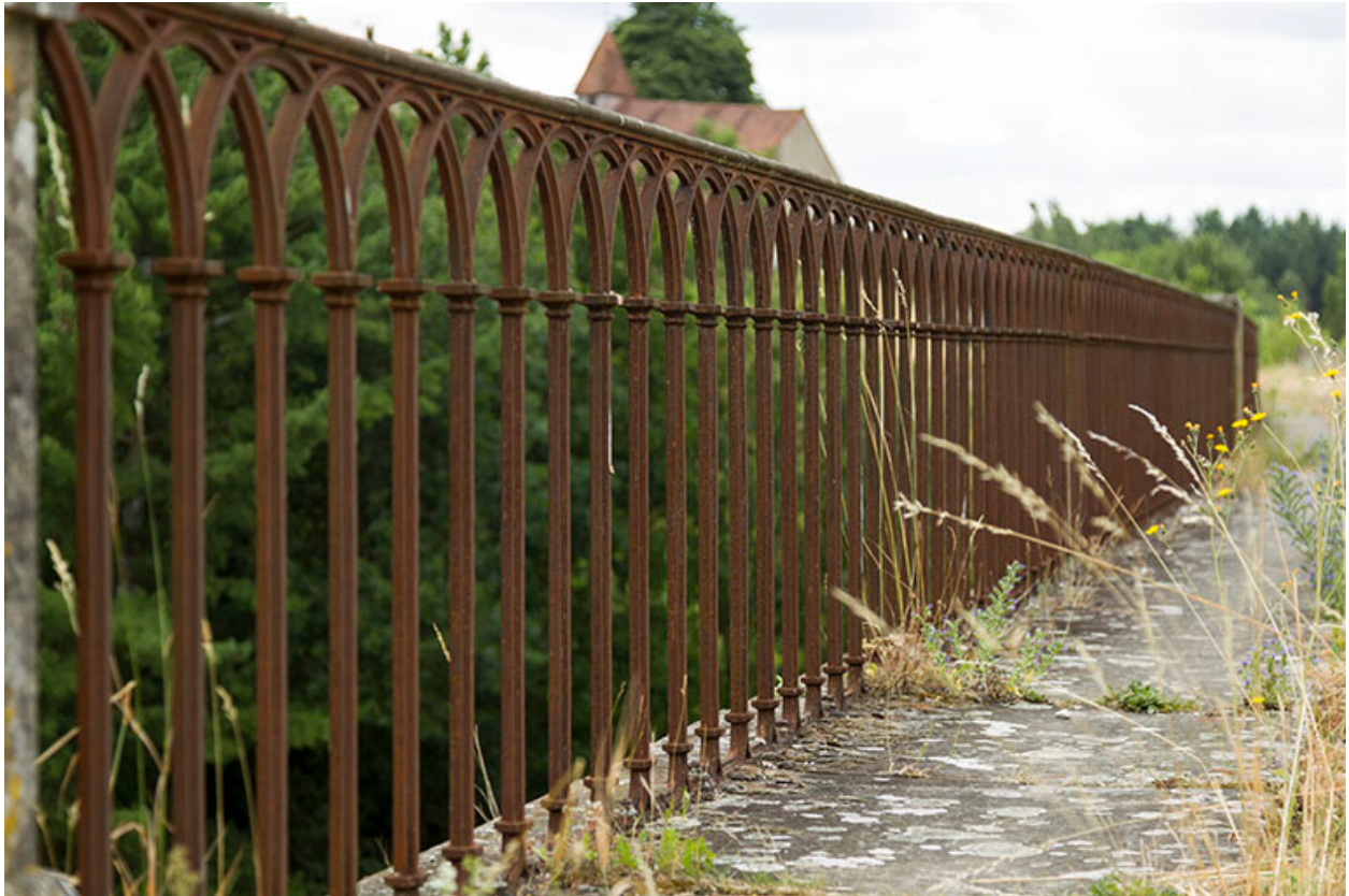
Détail du garde-corps.
