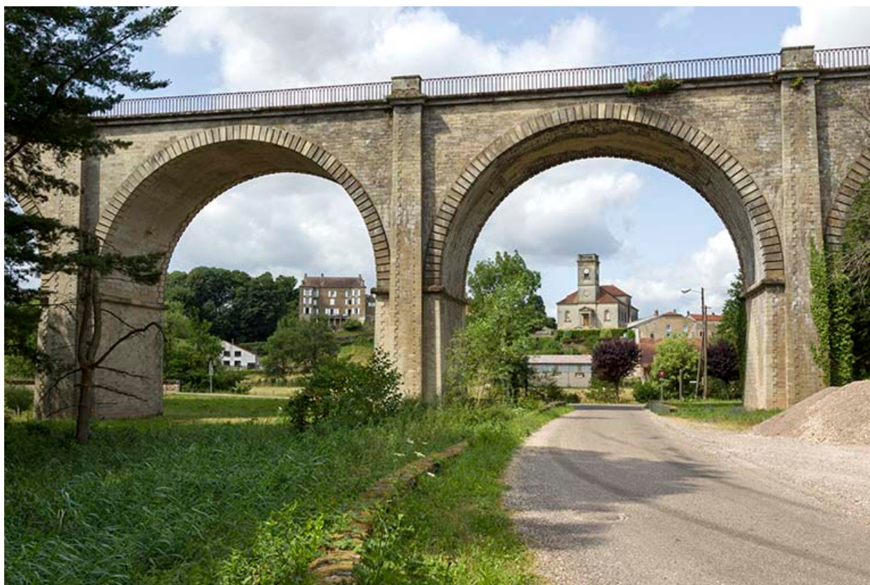
Vue d'ensemble depuis la rue des Forges.
