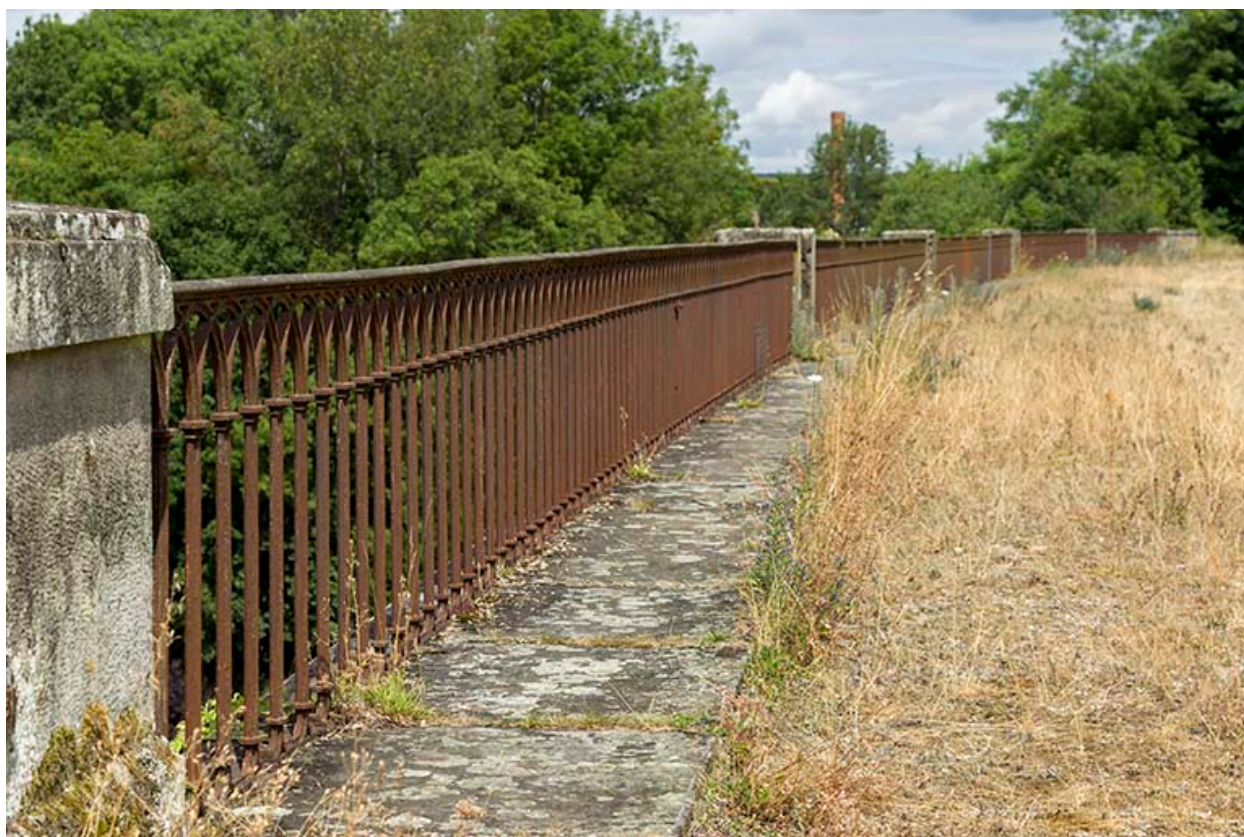
Les garde-corps en fonte.
