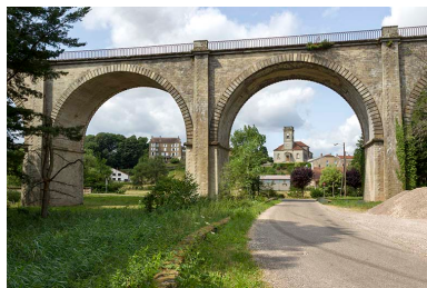
Vue d'ensemble depuis la rue des Forges. Phot. Sonia Dourlot IVR43_20157000581NUC2A
