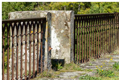
Le garde-corps maçonné d'une culée. Phot. Sonia Dourlot IVR43_20157000590NUC2A
