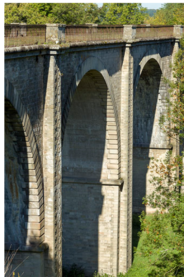
Vue des arches. Phot. Sonia Dourlot IVR43_20157000585NUC2A
