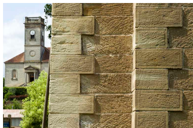
Détail de la maçonnerie des piles du viaduc. Phot. Sonia Dourlot IVR43_20157000583NUC2A
