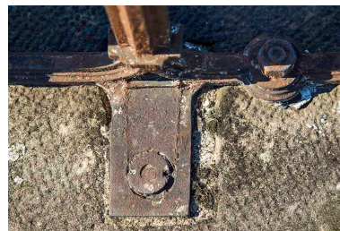
Détail de l'assemblage du garde- corps sur le tablier du viaduc. Phot. Sonia Dourlot IVR43_20157000591NUC2A
