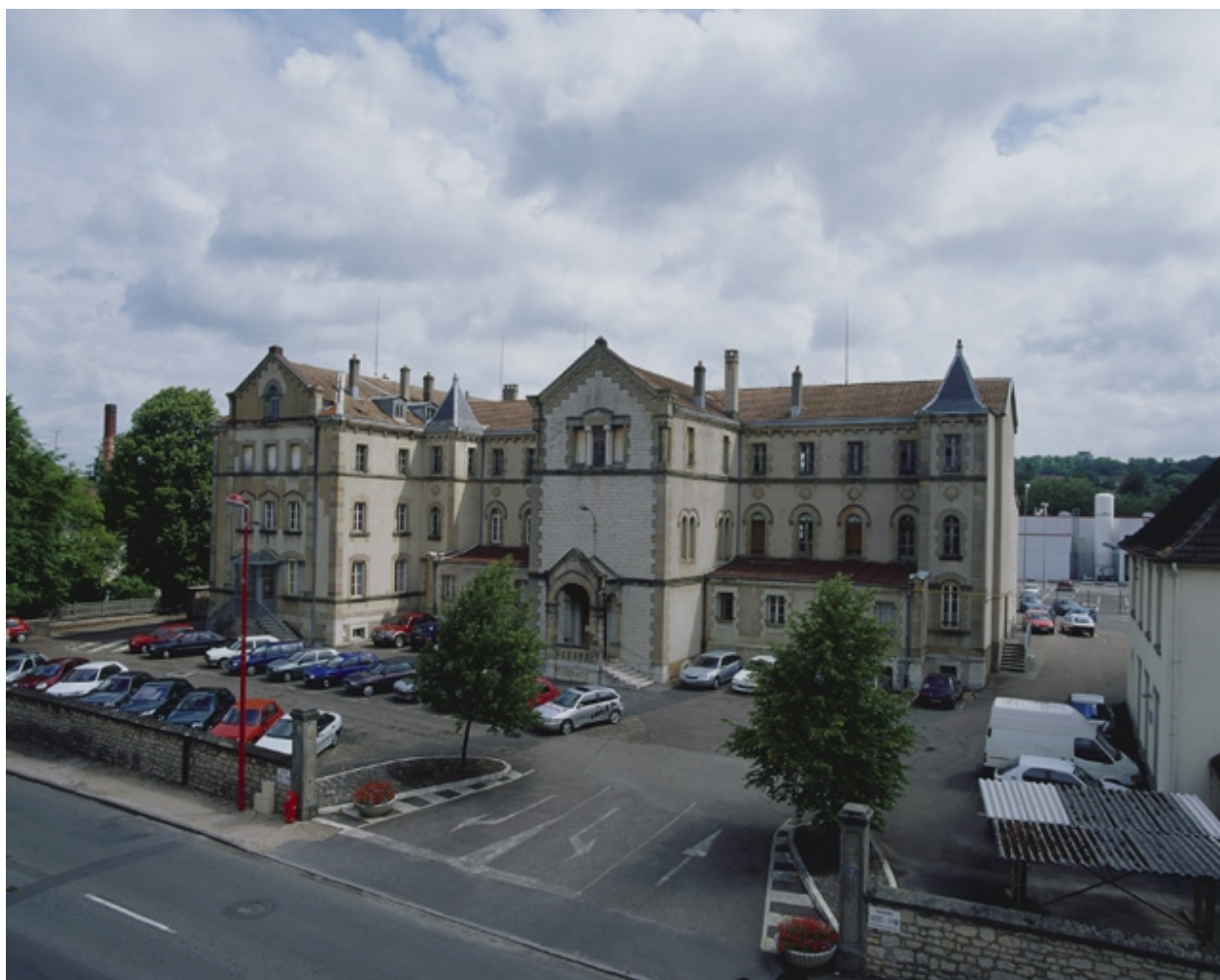
Vue d'ensemble de l'ancien couvent (actuellement bureaux).
