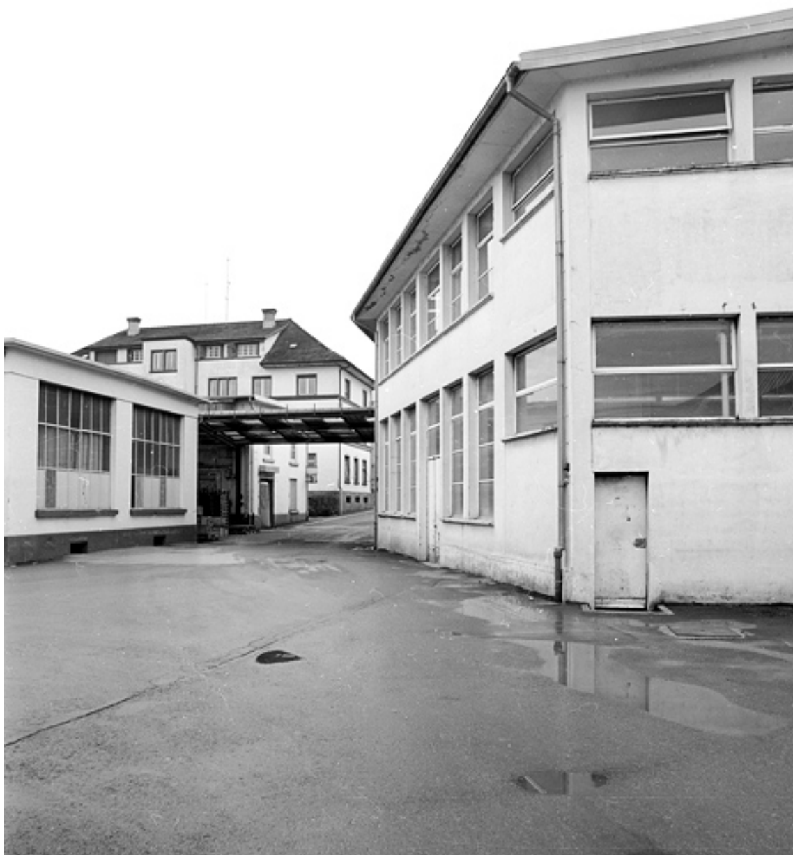
Bureaux et ateliers de fabrication.
