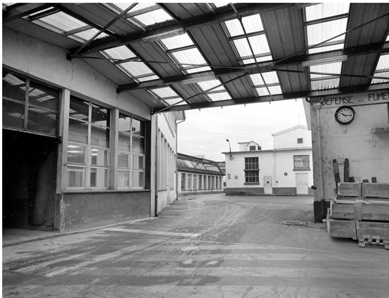
Ateliers de fabrication depuis l'est.
