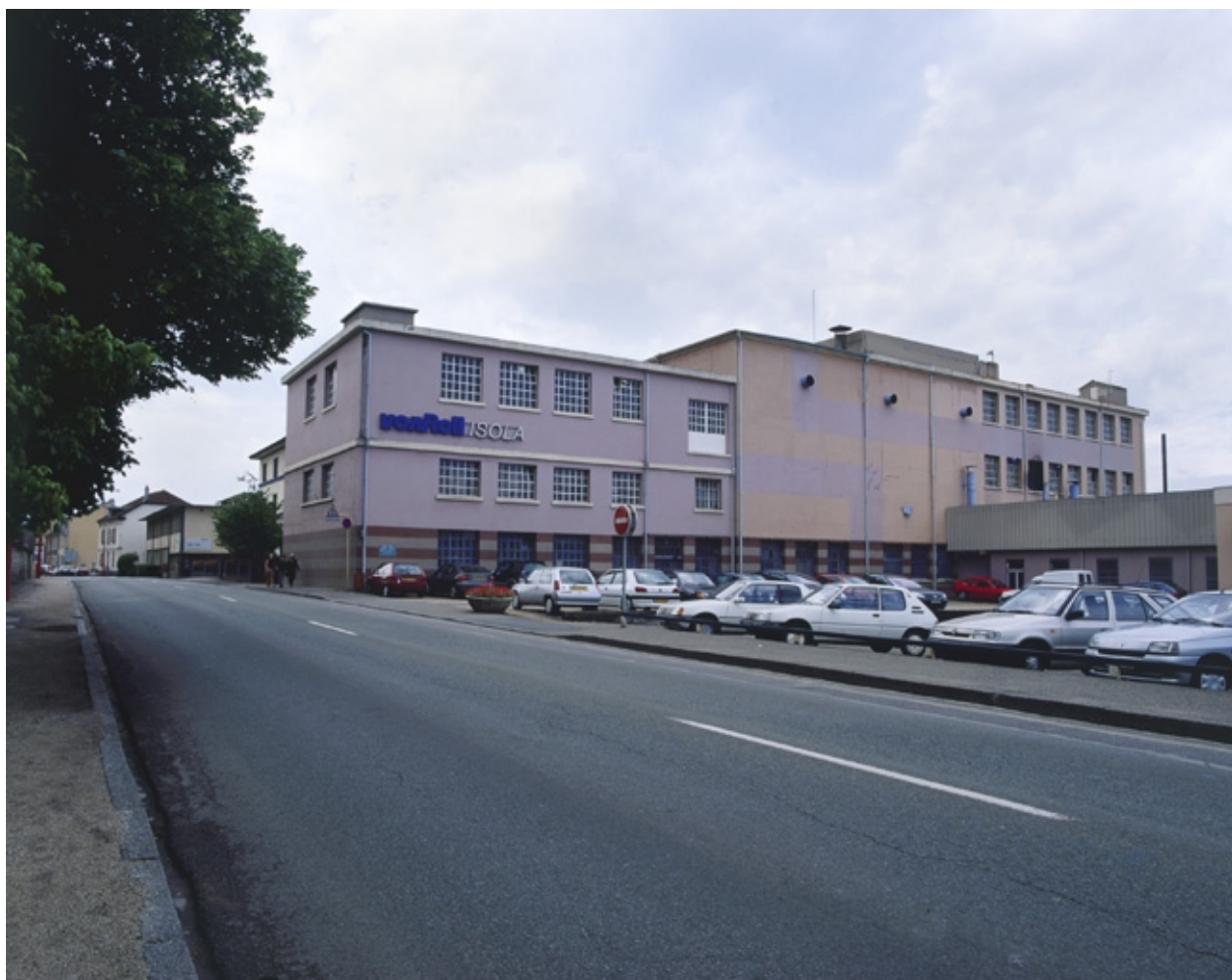
Atelier d'enduction verticale depuis le nord.
