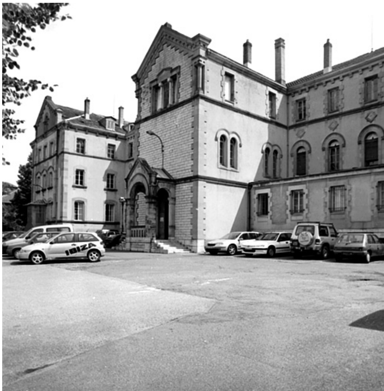
Façade antérieure de l'ancien couvent (actuellement bureaux).
