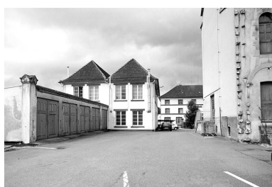
Remises et laboratoire depuis l'est. Phot. Yves Sancey IVR43_20029000442X
