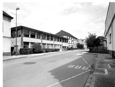
Façades sur rue de bâtiments administratifs. Phot. Yves Sancey IVR43_20029000430X
