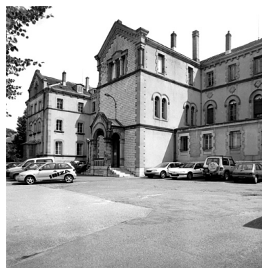
Façade antérieure de l'ancien couvent (actuellement bureaux). Phot. Yves Sancey IVR43_20029000437X
