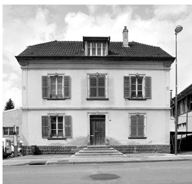
Infirmierie et bureaux. Phot. Yves Sancey IVR43_20029000433X
