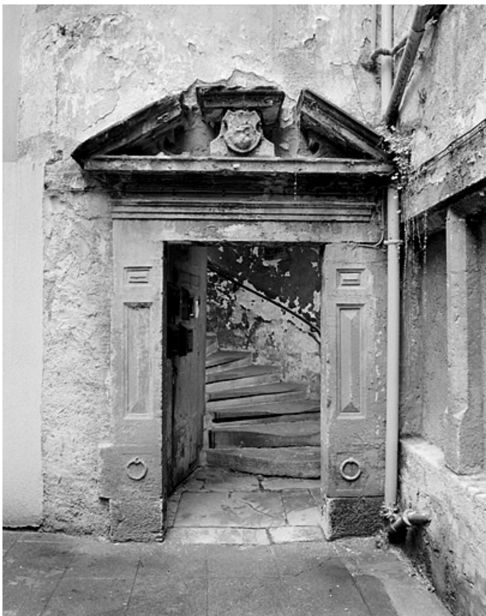
Porte de la tour d'escalier.
