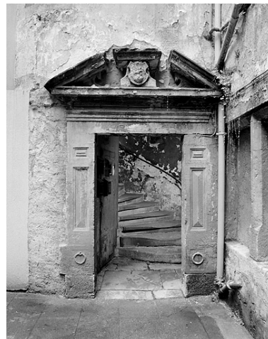
Porte de la tour d'escalier.
