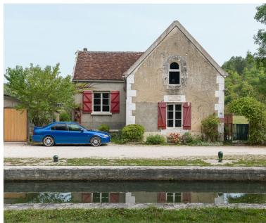
Vue de la maison éclusière.
