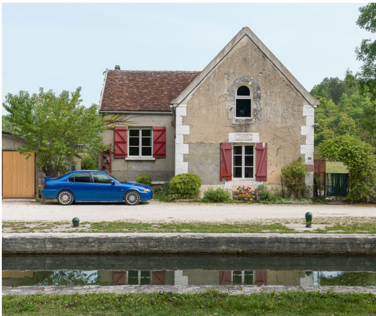
Vue de la maison éclusière.
