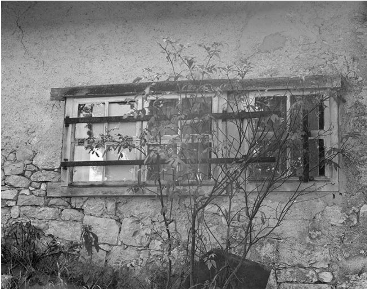
Fenêtres d'ateliers ou " fenêtres de forge ".
