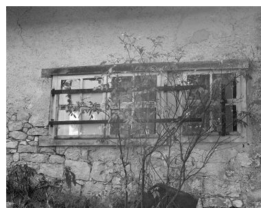
Fenêtres d'ateliers ou " fenêtres de forge ". Phot. Jérôme Mongreville IVR43_20003900445X
