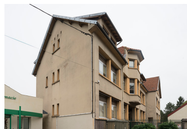
Bâtiment d'entrée vu de trois quarts. Phot. Jérôme Mongreville IVR43_20172501356NUC4A
