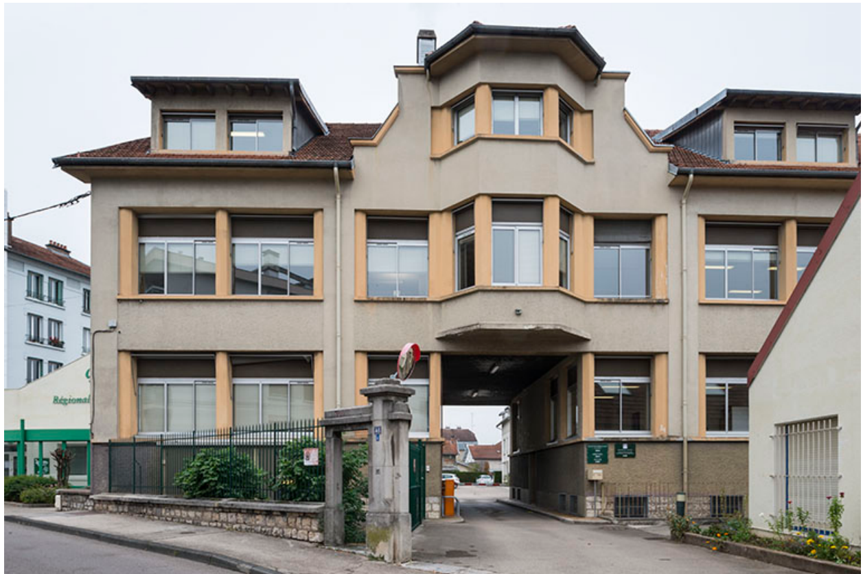
Bâtiment d'entrée. Façade antérieure.
