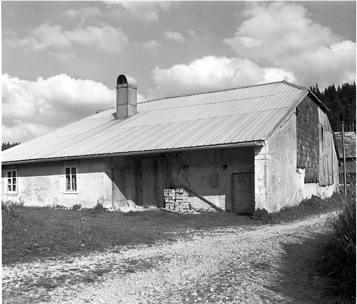
Façades postérieure et latérale gauche.
