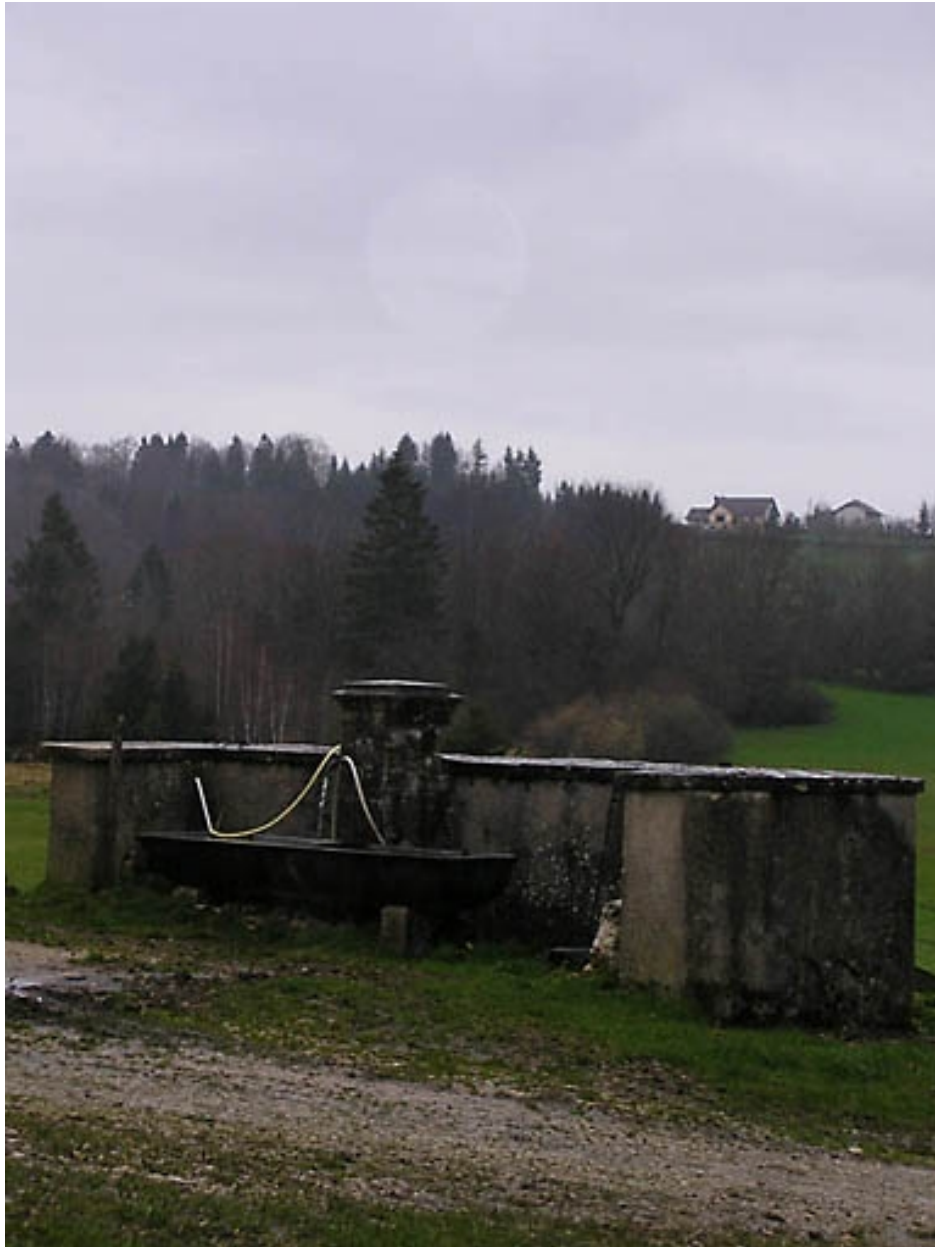
Vue de la fontaine abreuvoir.
