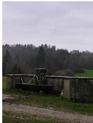
Vue de la fontaine abreuvoir.
