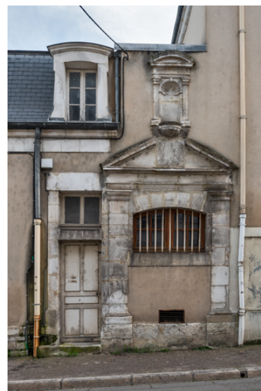
Façade latérale gauche en 2022, avant transformation : entrée des loges d'acteur et ancienne entrée murée. Phot. Pierre-Marie Barbe-Richaud IVR26_20228900040NUC4A
