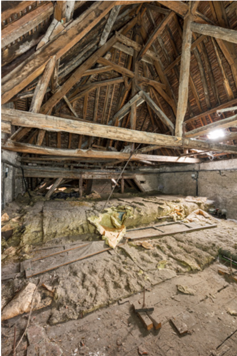
Le comble et sa charpente en 2022, avant transformation.
