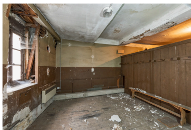
Ancienne loge d'acteur, côté rue, en 2022, avant transformation. Phot. Pierre-Marie Barbe-Richaud IVR26_20228900031NUC4A
