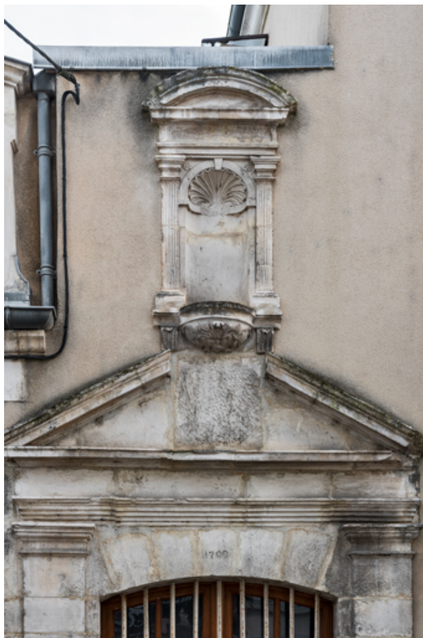
Façade latérale gauche en 2022, avant transformation : fronton et niche surmontant l'entrée murée.
