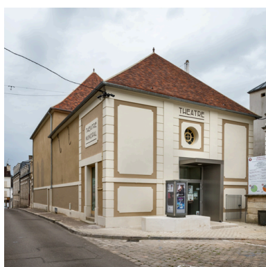
Façades antérieure et latérale gauche. Phot. Pierre-Marie Barbe-Richaud IVR26_20248900069NUC2A
