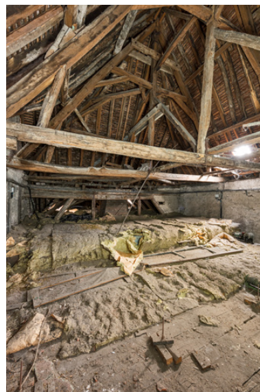
Le comble et sa charpente en 2022, avant transformation. Phot. Pierre-Marie Barbe-Richaud IVR26_20228900029NUC4A
