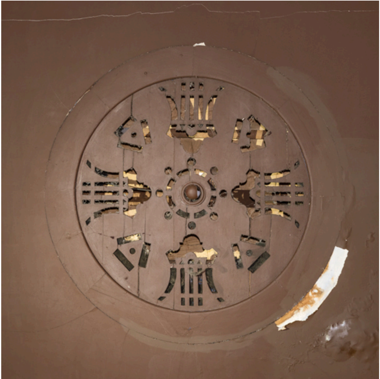
Ancien système d'aération au plafond en 2022, avant transformation.
