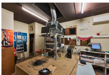
La cabine de projection en 2022, avant transformation. Phot. Pierre-Marie Barbe-Richaud IVR26_20228900039NUC4A
