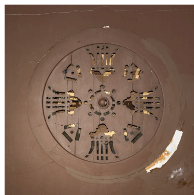
Ancien système d'aération au plafond en 2022, avant transformation. Phot. Pierre-Marie Barbe-Richaud IVR26_20228900036NUC2A
