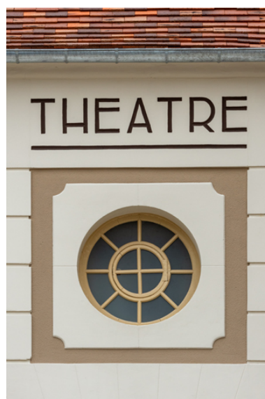
Façade antérieure : oculus. Phot. Pierre-Marie Barbe-Richaud IVR26_20248900068NUC4A
