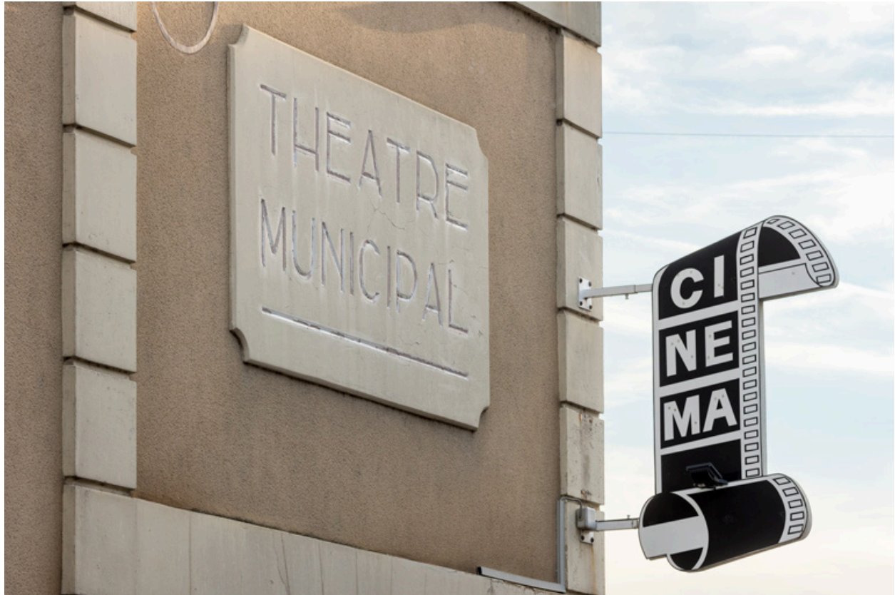
Façade latérale gauche en 2022, avant transformation : inscription Théâtre municipal et enseigne du cinéma.
