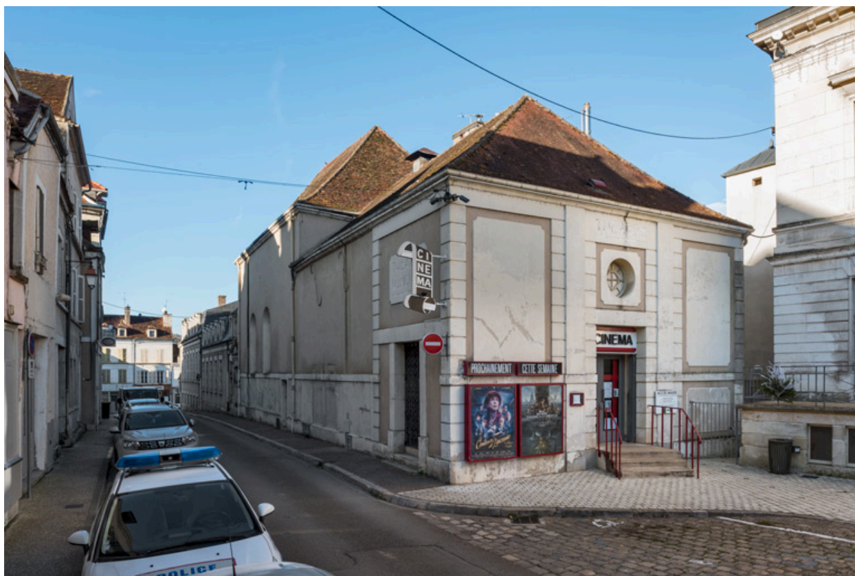
Façades antérieure et latérale gauche en 2022, avant transformation.
