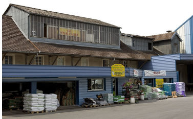
Façade antérieure de la minoterie. Phot. Jérôme Mongreville IVR43_20067000539NUCA
