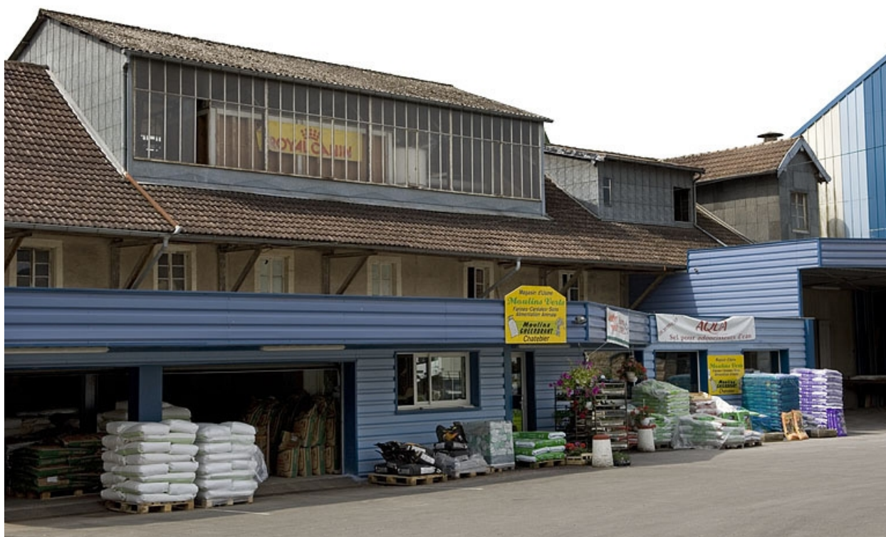
Façade antérieure de la minoterie.
