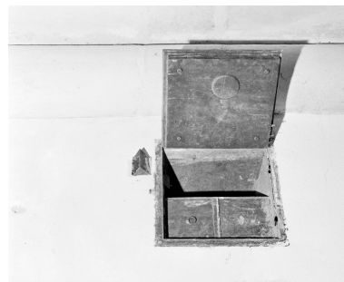
Tronc-coffre fort ouvert. Phot. Jean-Luc Duthu IVR26_19955801139X
