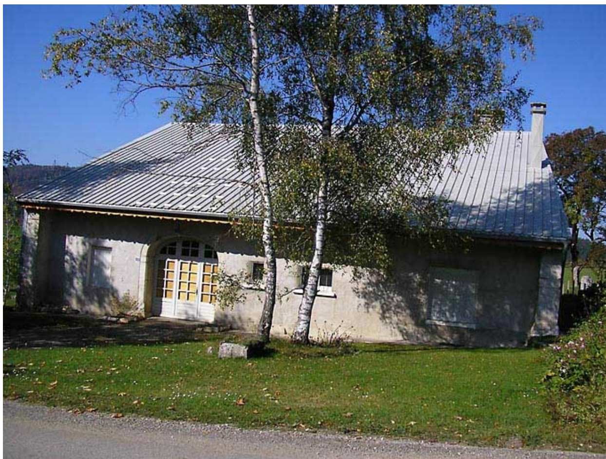
Vue latérale de la façade postérieure.
