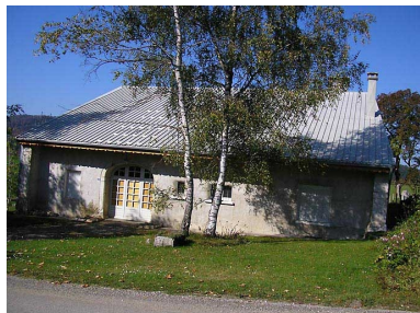
Vue latérale de la façade postérieure.
