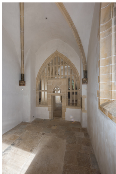
Vue intérieure de chapelle vers le nord. Phot. Pierre-Marie Barbe-Richaud IVR26_20237100297NUC4A
