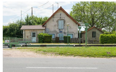
Vue de face de la maison éclusière.
