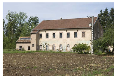
Façade orientale de l'atelier de filature. Phot. Jérôme Mongreville IVR43_20077000155NUCA
