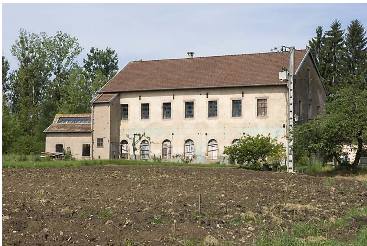
Façade orientale de l'atelier de filature.
