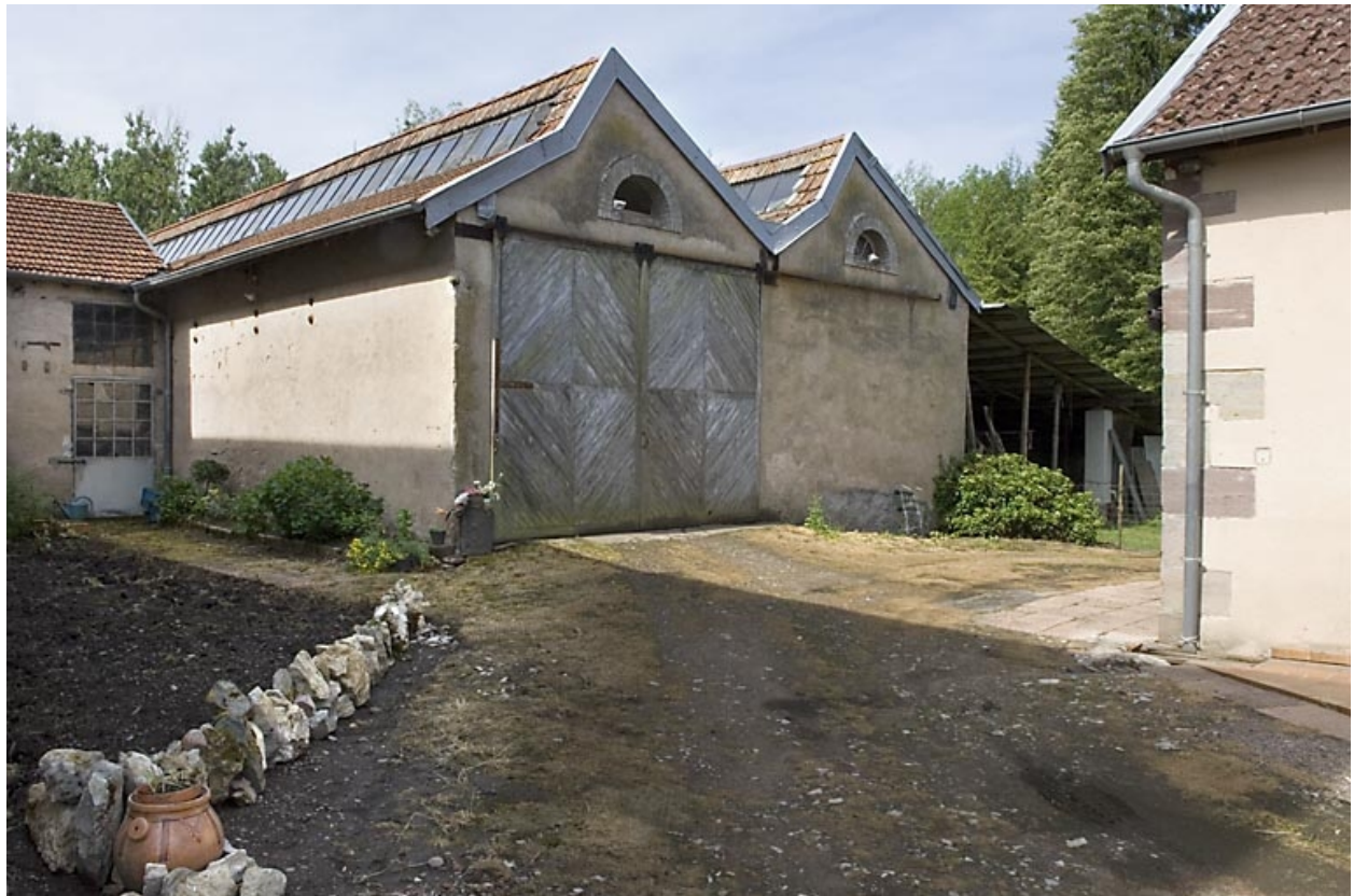
Extension ouest (atelier de fabrication ?).
