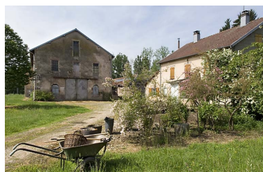
Atelier de filature et logement depuis l'est. Phot. Jérôme Mongreville IVR43_20077000156NUCA
