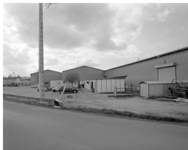
Atelier de fabrication et bungalow (A). Phot. Yves Sancey IVR43_19943901650X
