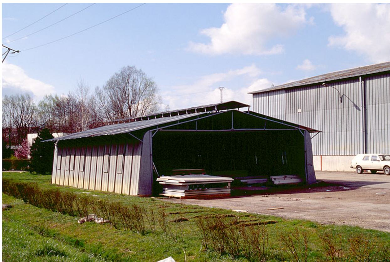
Entrepôt industriel (E).
