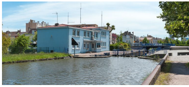
La subdivision de Montceau-les-Mines. Phot. Pierre-Marie Barbe-Richaud IVR26_20137100421NUC4AQ
