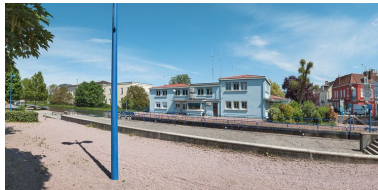
La subdivision de Montceau-les-Mines. Phot. Pierre-Marie Barbe-Richaud IVR26_20137100420NUC2AQ
