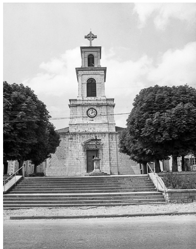
Extérieur : face antérieure. Phot. Yves Sancey IVR43_19752500224X
