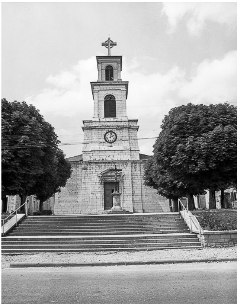
Extérieur : face antérieure.
