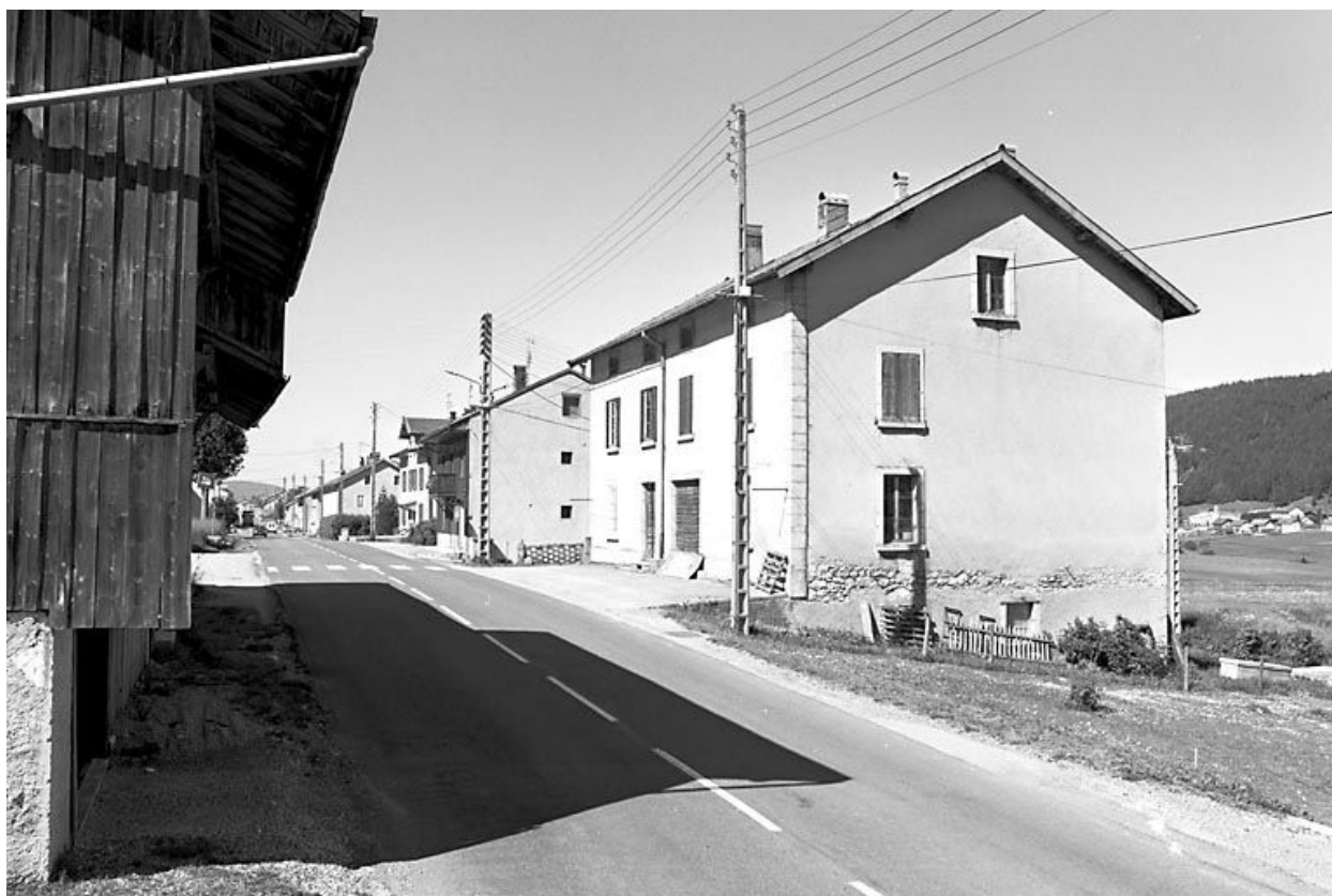
Ferme située au lieudit Les Meuniers.
