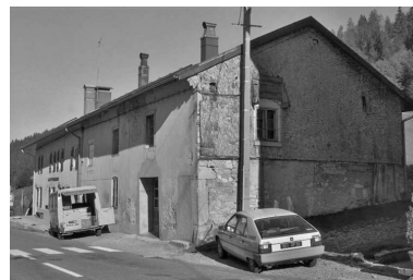
Scierie située au lieudit La Frontière. Phot. Laurent Poupard IVR43_19903900665Z
