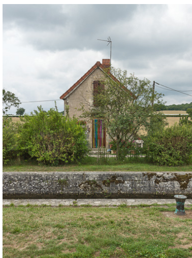
Vue du premier sas et de la maison éclésièr. Phot. Pierre-Marie Barbe-Richaud IVR26_20175800310NUC2A
