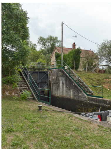
Vue du second sas. Phot. Pierre-Marie Barbe-Richaud IVR26_20175800312NUC2A
