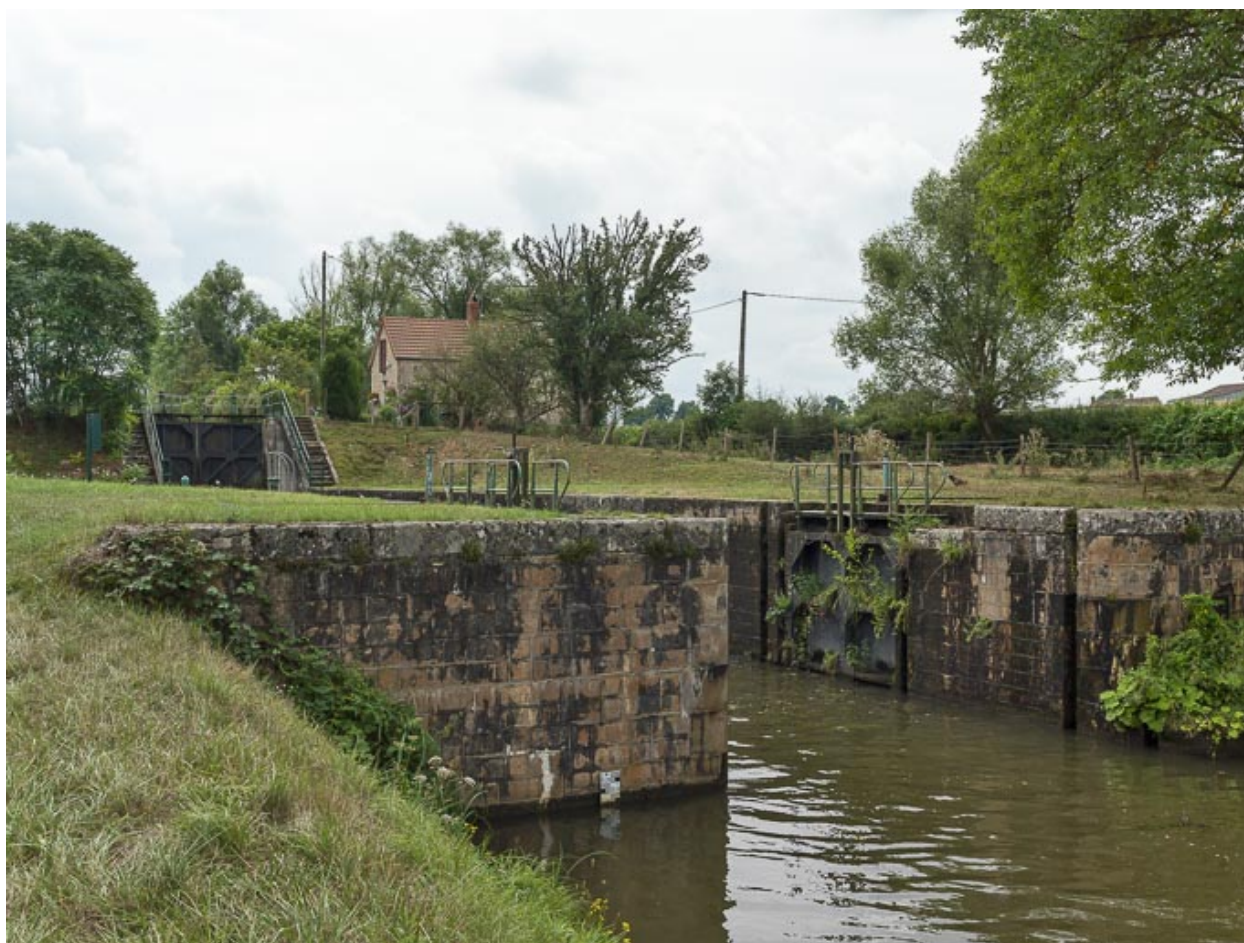
Le second sas, vu d'aval.
