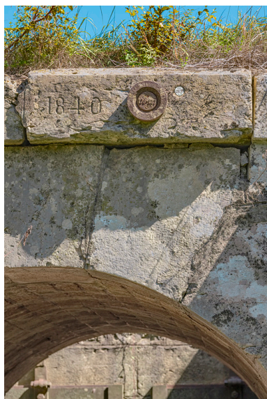
La date de 1840 gravée sur le pont, côté Saône. Phot. Thierry Kuntz IVR26_20197100520NUC4A
