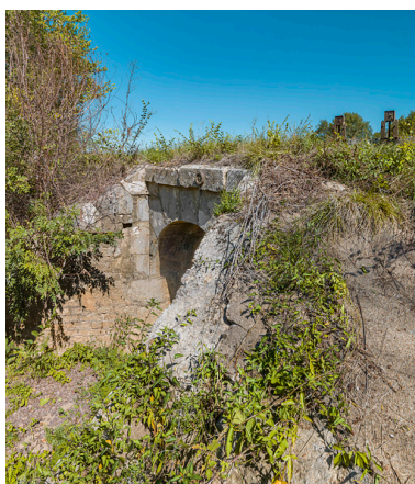
Vue d'ensemble du ponceau et des vannes, rive gauche. Phot. Thierry Kuntz IVR26_20197100518NUC4A
