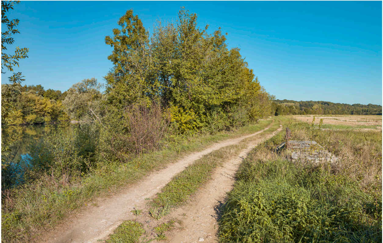
Le chemin de halage au niveau du ponceau : à droite le système de vannes sur la Raie du Grand Meix.
