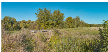
Le ponceau dans son environnement. Phot. Thierry Kuntz IVR26_20197100517NUC4A
