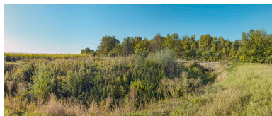
Le ponceau dans son environnement. Phot. Thierry Kuntz IVR26_20197100516NUC4A
