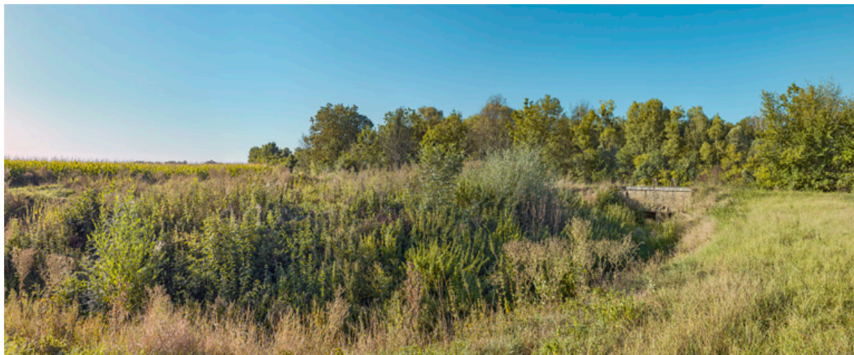
Le ponceau dans son environnement.
