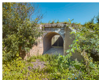
Vue d'ensemble du ponceau et des vannes, rive gauche. Phot. Thierry Kuntz IVR26_20197100519NUC4A
