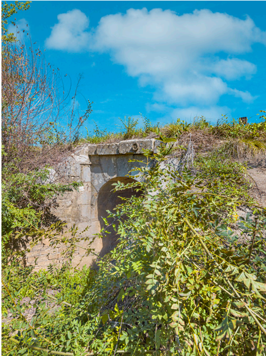
Le ponceau avec ses murs en aile, côté Saône.
