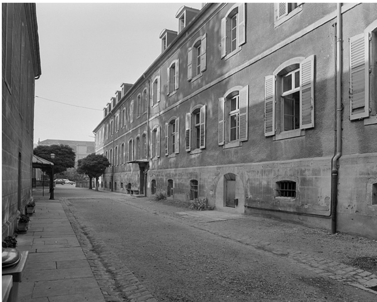
Bâtiment principal, façade sur la cour.
