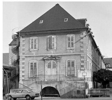
Bâtiment principal, façade sud. Phot. Yves Sancey IVR43_19833900468X
