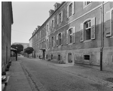
Bâtiment principal, façade sur la cour. Phot. Yves Sancey IVR43_19833900467X
