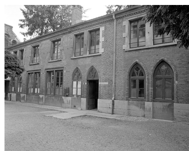
Bâtiment annexe, détail. Phot. Yves Sancey IVR43_19833900471X
