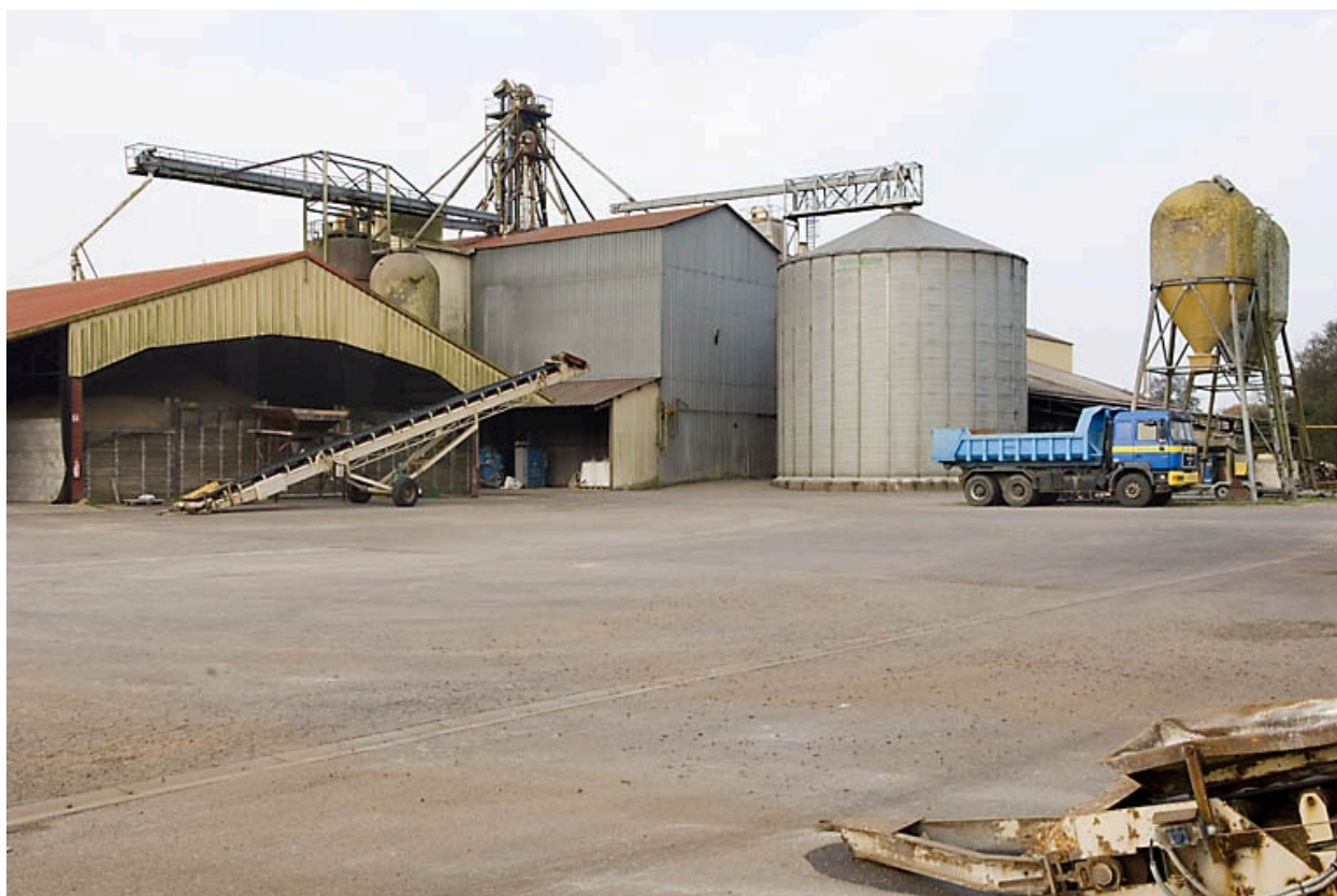
Silos et entrepôts industriels depuis l'arrière.
