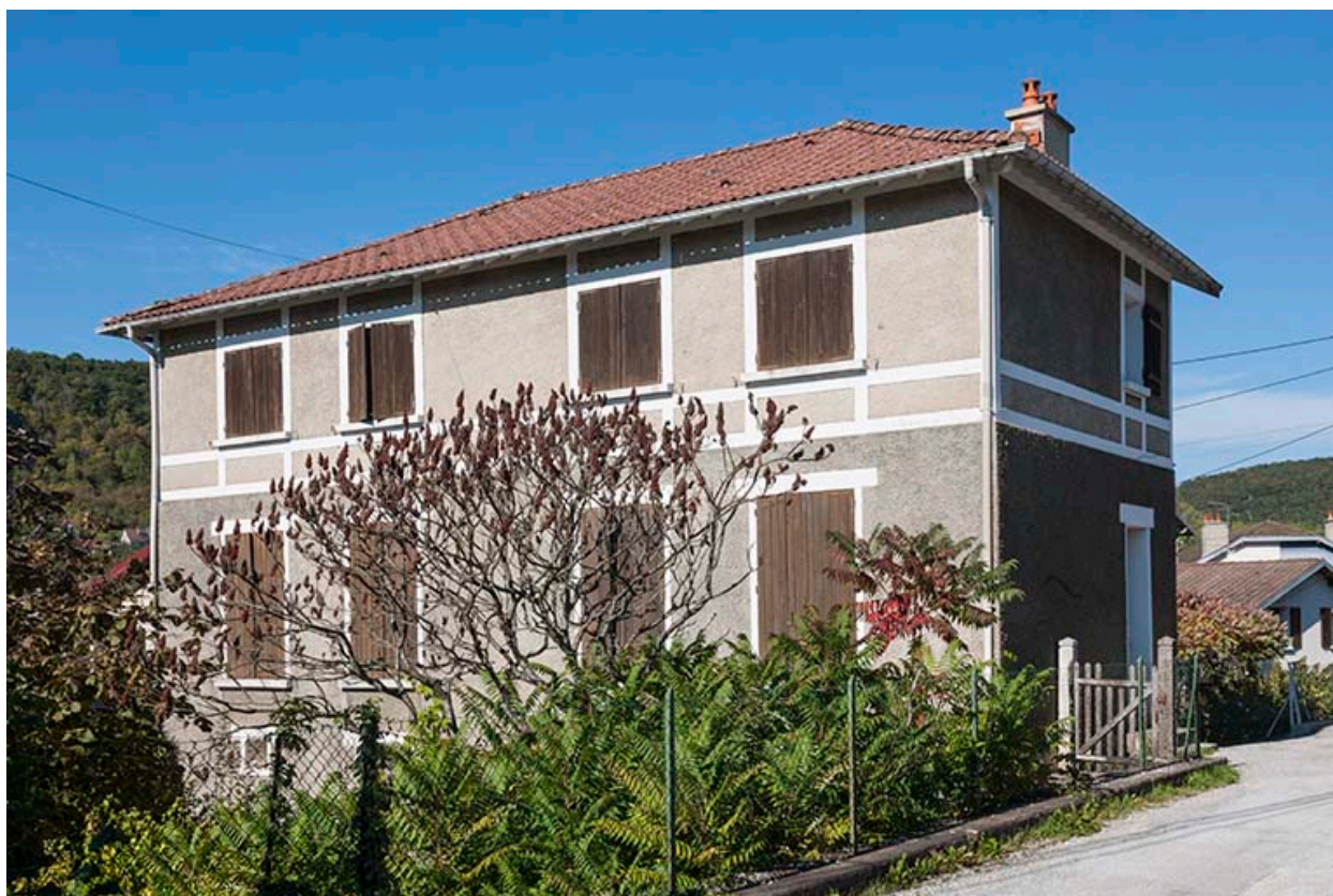
Façade postérieure d'une maison de célibataires.
