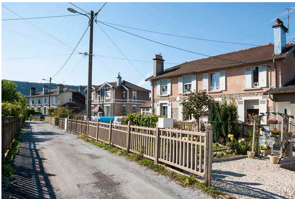
Maisons ouvrières rue Roger Salengro.
