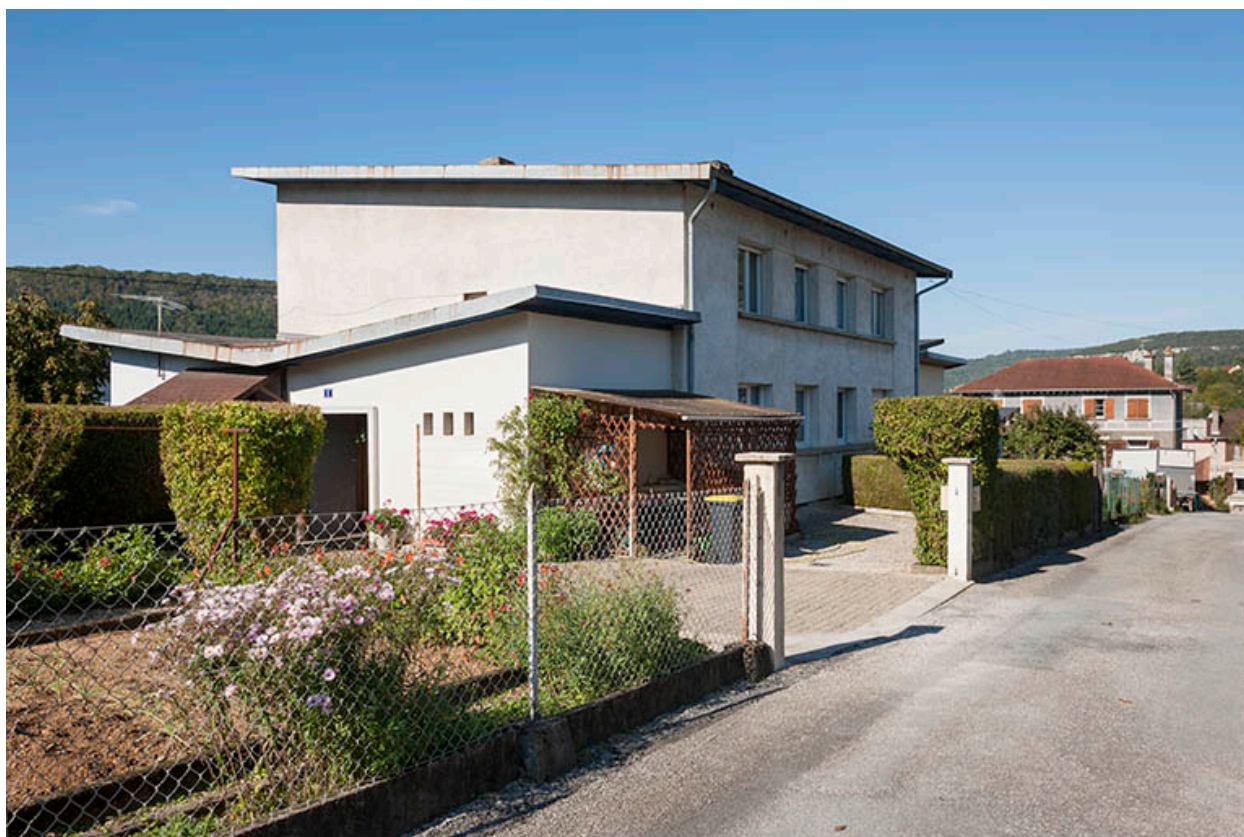
Maison à quatre logements (années 1950).
