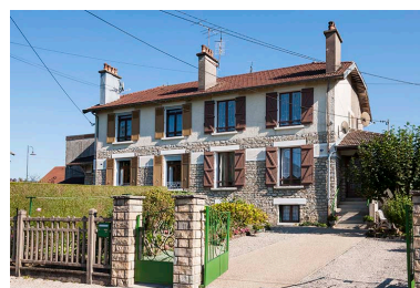
Façade antérieure d'une habitation à quatre logements. Phot. Jérôme Mongreville IVR43_20162500472NUC4A
