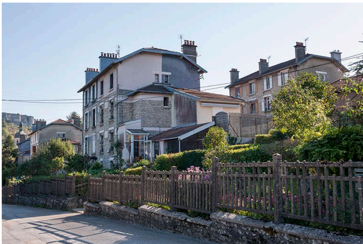
Maisons à quatre logements depuis l'avenue Tournier.
