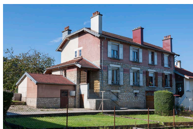
Maison à quatre logements. Vue trois quarts. Phot. Jérôme Mongreville IVR43_20162500458NUC4A
