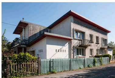
Maison (années 1950) vue de trois quarts droite. Phot. Jérôme Mongreville IVR43_20162500468NUC4A
