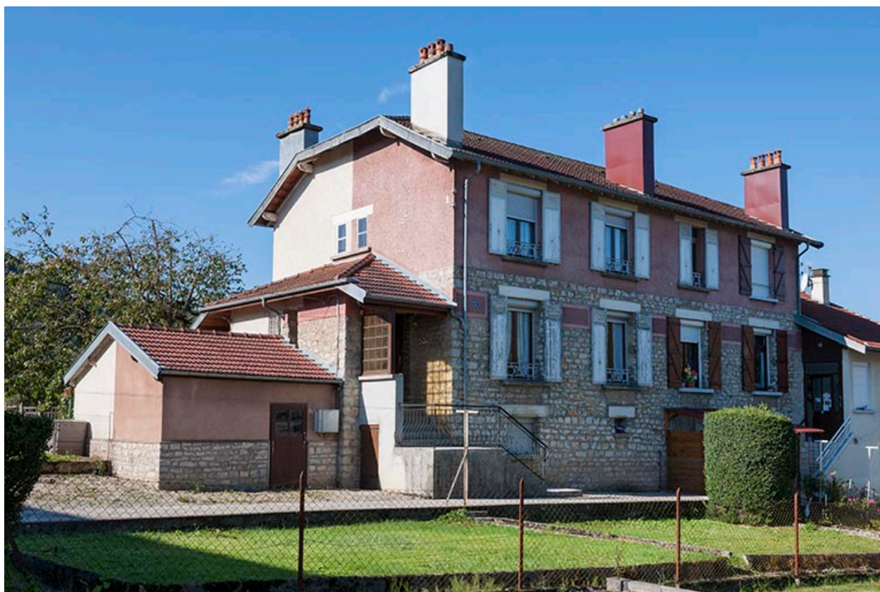
Maison à quatre logements. Vue trois quarts.
