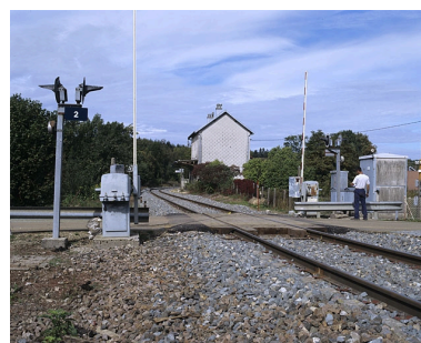
Vue d'ensemble depuis le passage à niveau n° 2, au sud. Phot. Yves Sancey IVR43_20043900121XA
