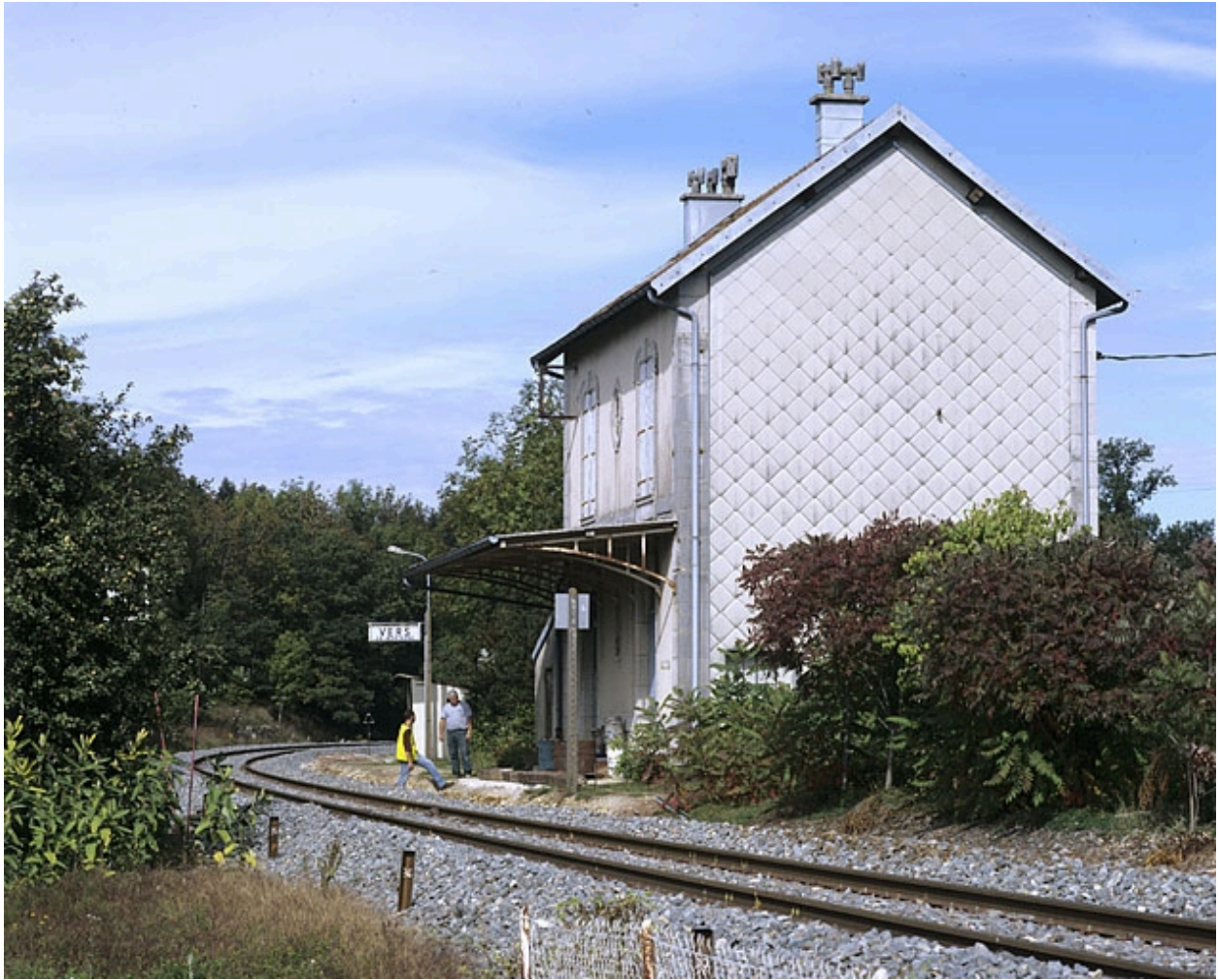
Façades postérieure et latérale gauche.
