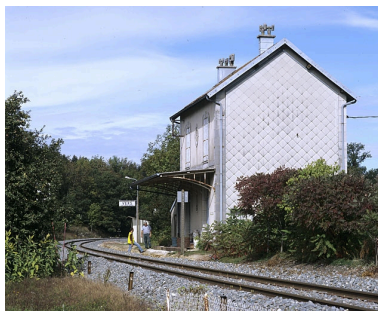
Façades postérieure et latérale gauche.
