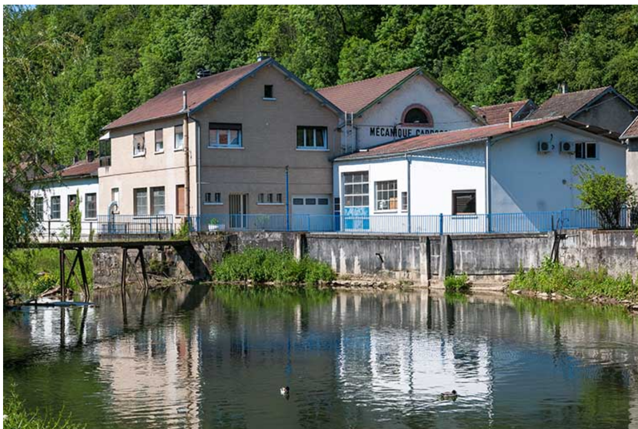
Vue du pont, depuis l'amont.
