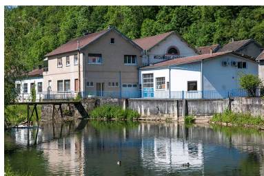
Vue du pont, depuis l'amont. Phot. Jérôme Mongreville IVR43_20142501322NUC4A
