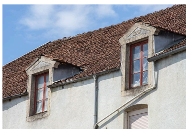
Les deux lucarnes du surcroît. Phot. Jérôme Mongreville IVR43_20217000262NUC4A
