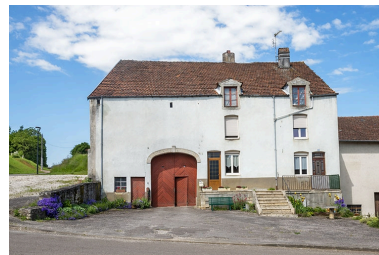
La façade antérieure depuis la rue. Phot. Jérôme Mongreville IVR43_20217000261NUC4A
