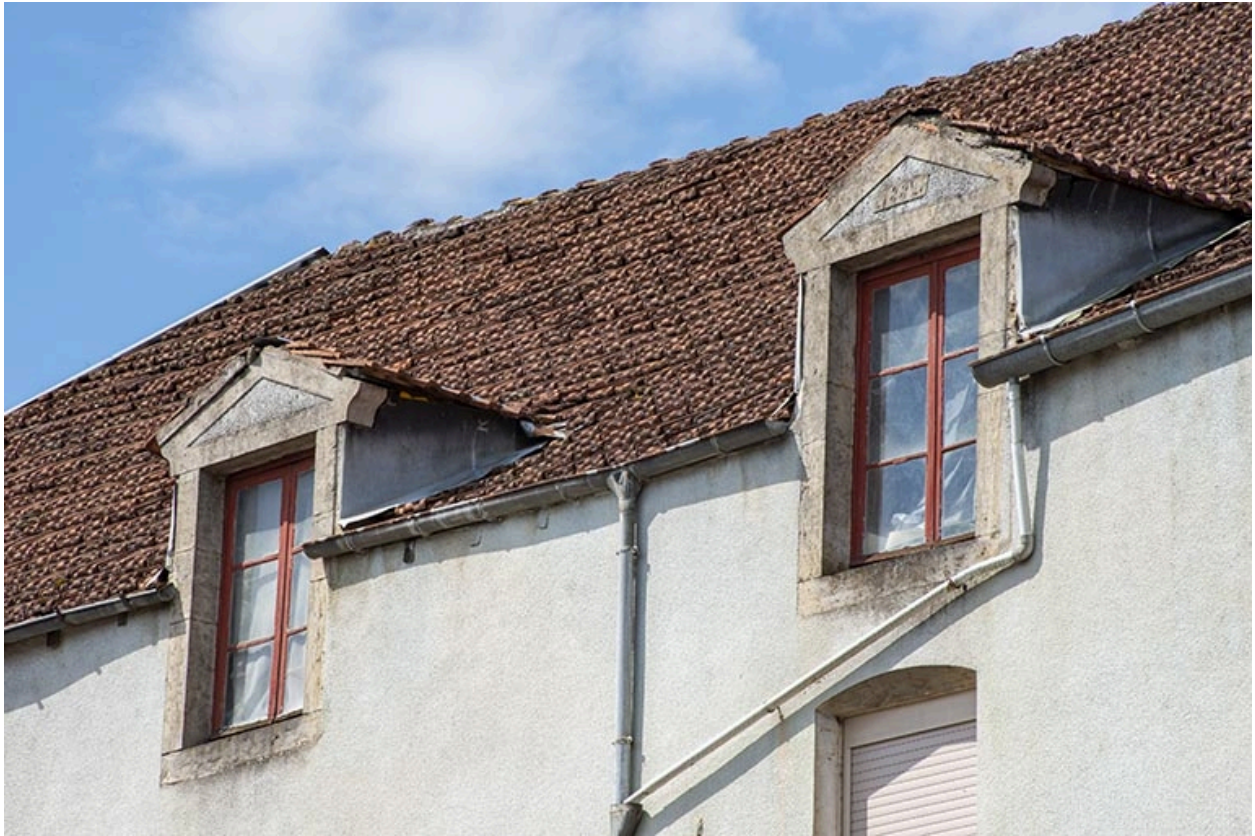
Les deux lucarnes du surcroit.
