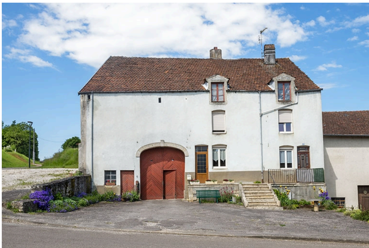
La façade antérieure depuis la rue.
