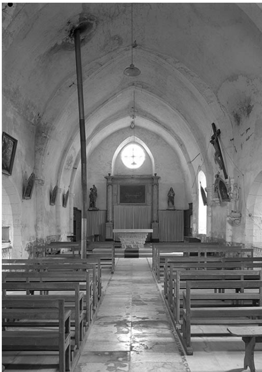
Vue intérieure vers le chœur.
