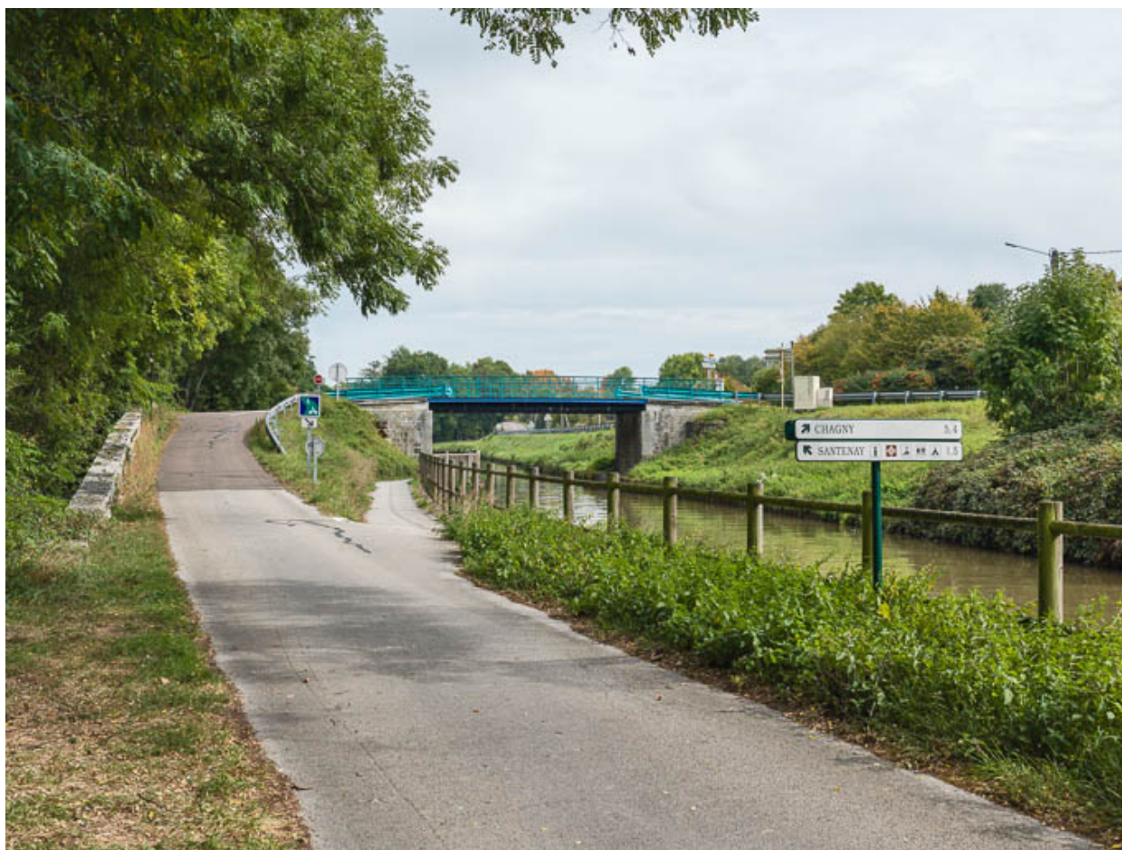
Vue d'ensemble du pont.
