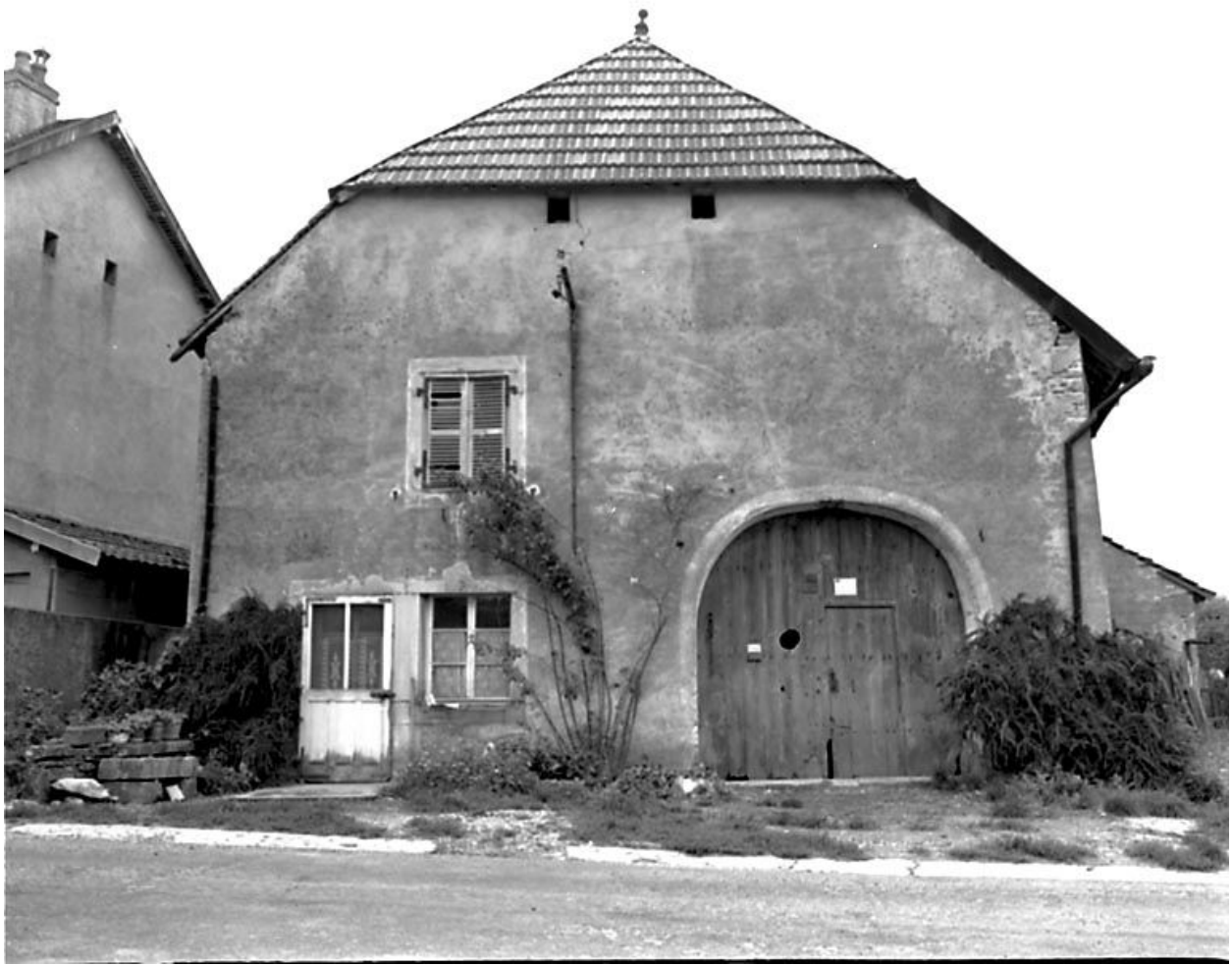
Façade antérieure à deux travées.
