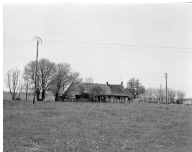
Vue générale. Phot. Bernard Lardière IVR43_19793900318X
