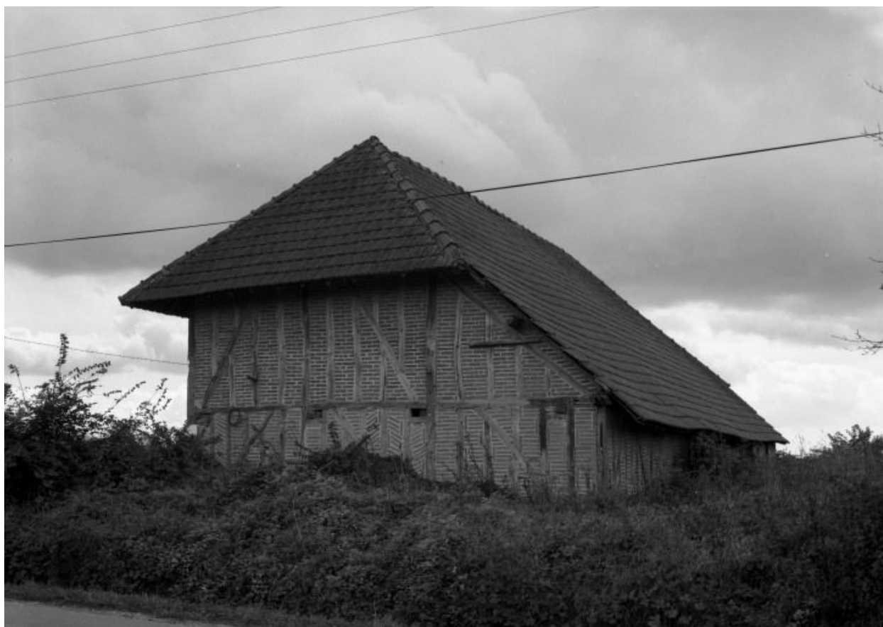
Elévations latérale et postérieure.
