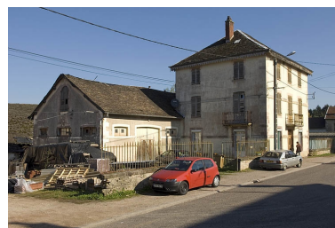
Entrepôt industriel et logement patronal. Phot. Jérôme Mongreville IVR43_20067000827NUCA
