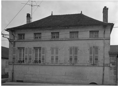
Façade sur rue. Phot. Michel Thierry IVR26_19748901336V
